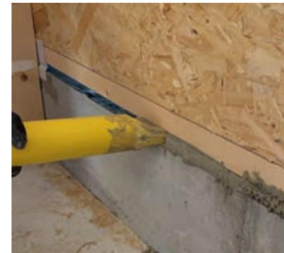
Unterfüllen von Holzständerkonstruktionen mit PCI Repaflow® USM
