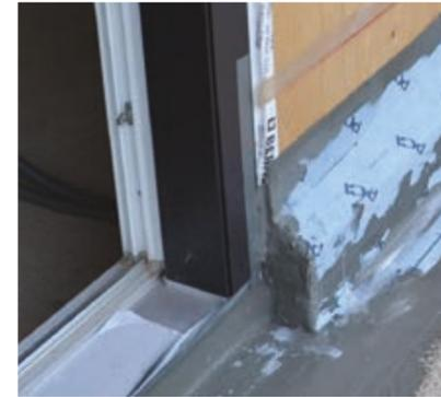
Einbetten von PCI Pecitape® 250 in das frische PCI Barraseal® Turbo
