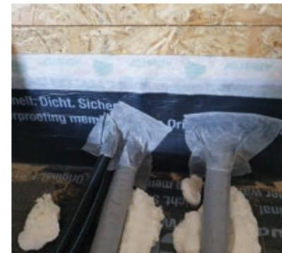
Wasserdampfsperrendes Abdichten unter Estrichen
