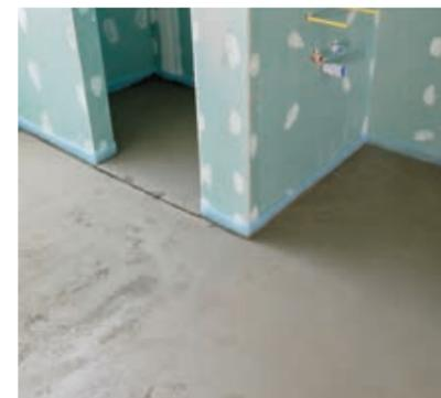
1 Stunde bearbeitbar, schnelle Durchtrocknung, bereits nach 6 Stunden begehbar
