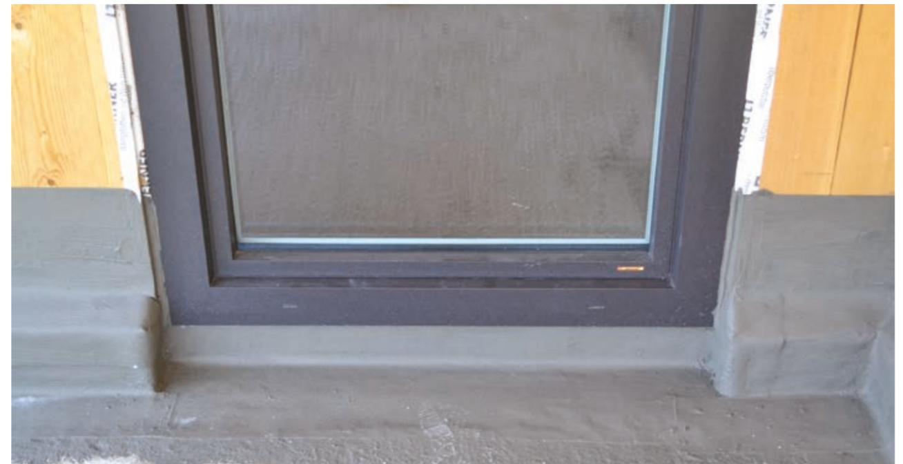
Mit Pecitape® 250 in Verbindung mit PCI Barraseal® Turbo abgedichtete Laibungsflächen sind leicht überputzbar und haftungsfreundlich (Richtlinie Sockelanschluss im Holzhausbau)
