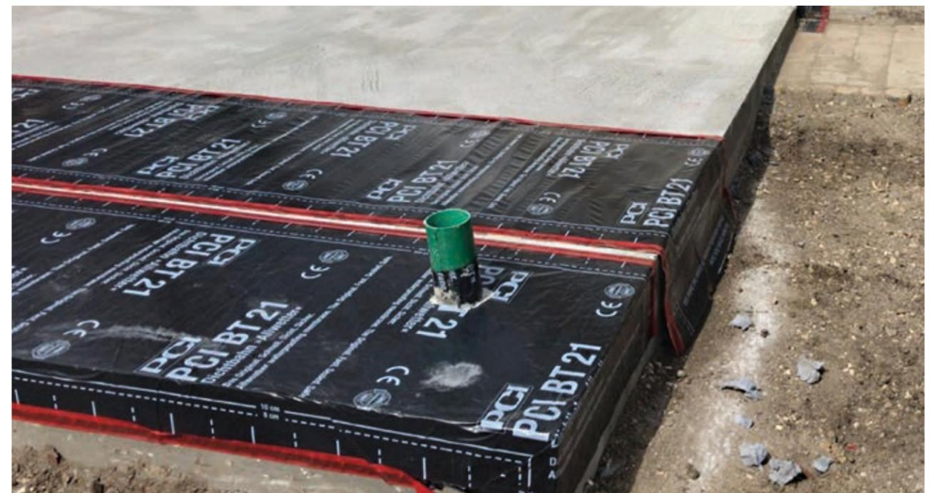
Betonbodenplatte wasserdampfsperrend mit PCI BT 21 abdichten
