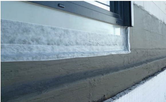
Geeignet auch als Sockel- und Putzabdichtung
