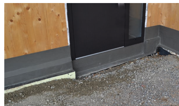
Anarbeiten der flexiblen mineralischen Dichtschlämme PCI Barraseal Turbo oder PCI Barraseal Turbo 1K an das Dichtband und Fensterelement
