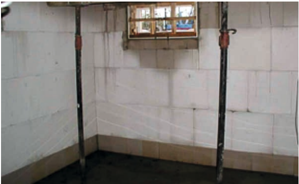
Durchfeuchtetes Kellermauerwerk
