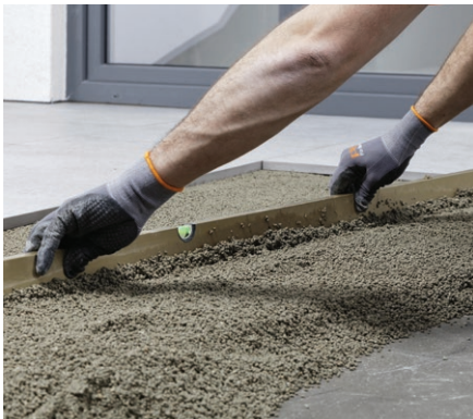
Abziehen des aufgetragenen Drainmörtels
