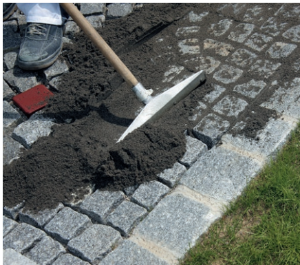
Einkehren des drainfähigen Fugenmörtels
