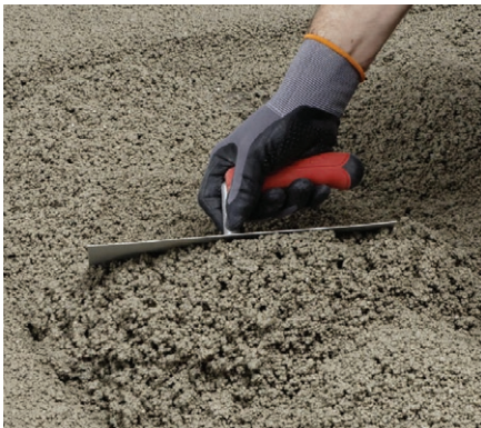
Ausbringen der Bettungsschicht
