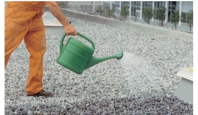
Verfestigung einer Kiesschüttung mit PCI Stabiflex.
