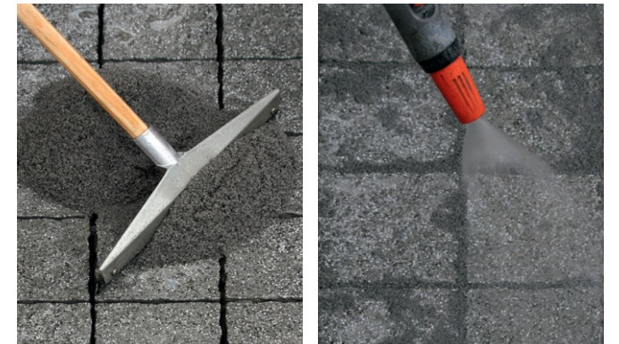
Material gleichmäßig in die Fugen verteilen. Die Mindestfugentiefe beachten! Während der Verarbeitung die Flächen ausreichend feucht halten.
