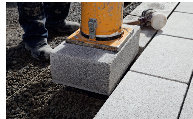
PCI Carrament wird als Haftbrücke verwendet und frisch in frisch in den Bettungsmörtel eingeklopft.
