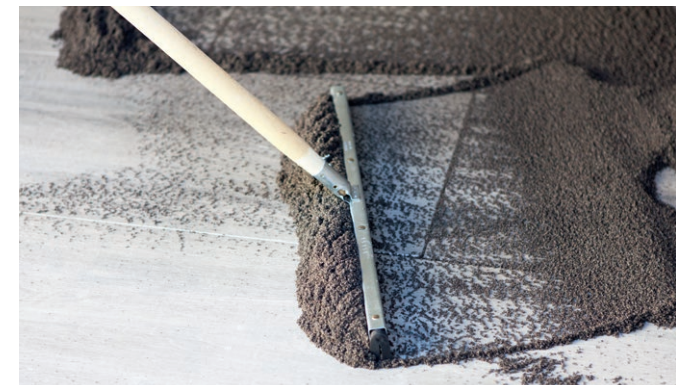
Den wasserdurchlässigen Fugenmörtel PCI Pavifix 1K Extra in die Fugen einbringen. Anschließend die Flächen sauber absputzen und abkehren.
