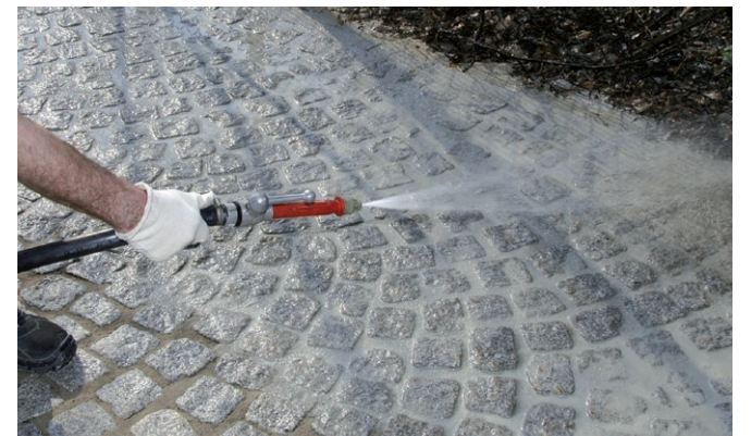
Die Flächen schräg zur Fuge „sanft“ abspülen.
