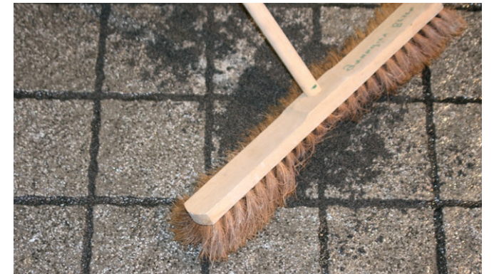
Überschüssiges Material mit weichem Besen abkehren und vorsichtig abspülen.
