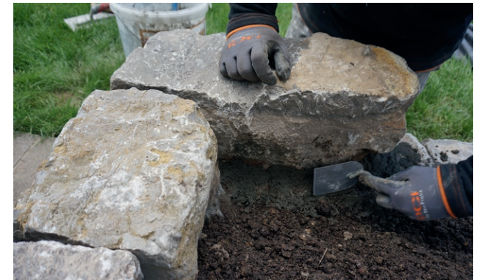
PCI Carraroc ist besonders geeignet für das Verlegen und Setzen von Platten und Mauern mit ungleichmäßiger Stärke.
