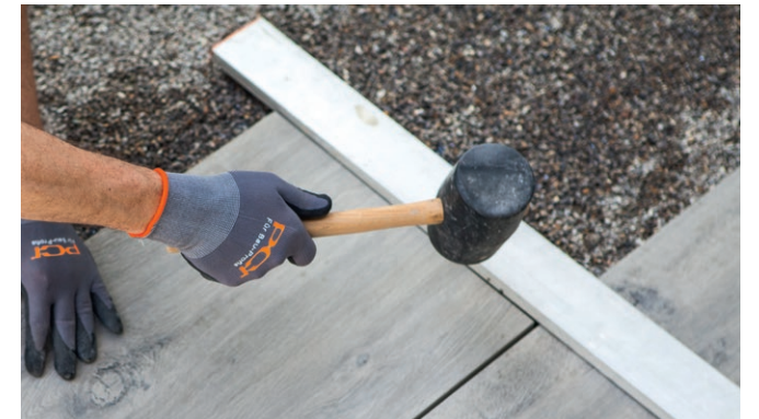
Auf die Platten rückseitig PCI Carrament als Haftbrücke/Kontaktschicht auftragen und fest in den Drainmörtel einklopfen.
