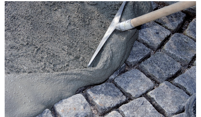
... und gleichmäßig verteilen.
