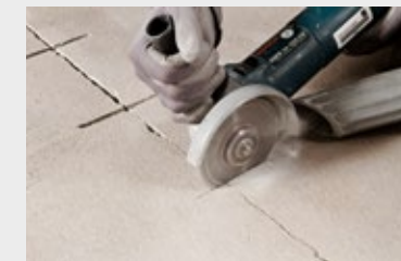
Zur Vorbereitung für eine Vernadelung rechtwinklig zum Rissverlauf Nuten einschneiden.
