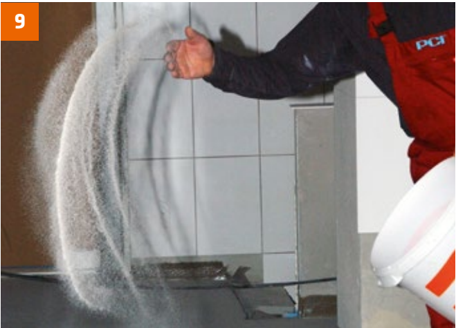
Zur besseren mechanischen Verkrallung mit dem Fliesenkleber, die 2K-Polyurethan-Abdichtung PCI Apoflex vollsatt mit Quarzsand abstreuen.
