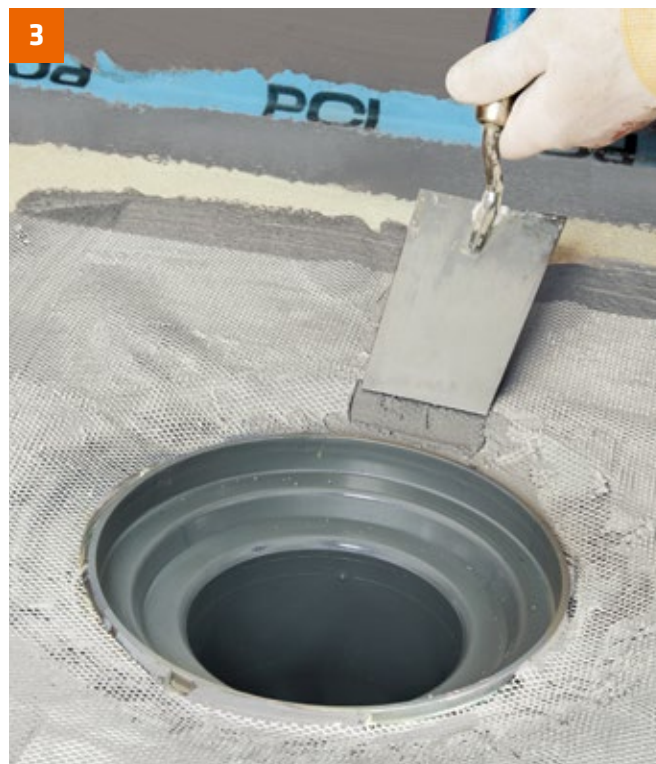
... anschließend das Gewebe entsprechend dem Gefälleverlauf andrücken und mit PCI Seccoral 1K / 2K Rapid überarbeiten. Nach Durchtrocknung (ca. 1 Stunde) erfolgt der 2. Arbeitsgang mit PCI Seccoral 1K / 2K Rapid.
