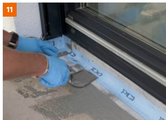
PCI Pecitape 120 in PCI Seccoral 2K Rapid einlegen.
