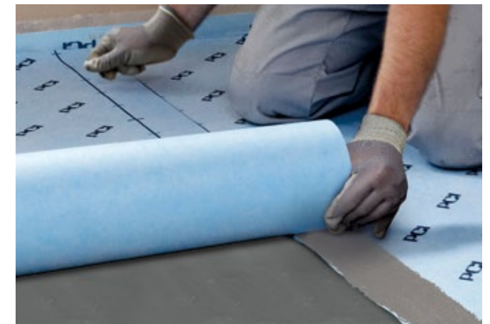
Die Stöße der Abdichtungsbahn PCI Pecilastic W müssen ca. 5 bis 10 cm überlappen. Die Überlappung der Bahnen mit dem Spezialkleber PCI Pecilastic W-Lim einstreichen und innerhalb der klebefreien Zeit die folgende Bahn einlegen und sorgfältig andrücken.
