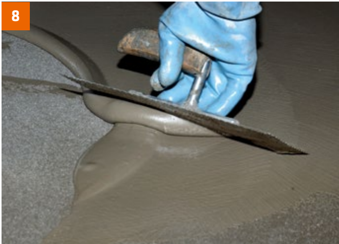
PCI Apoflex in der Wand- oder Bodenvariante als Verbundabdichtung in zwei Arbeitsgängen auftragen.
