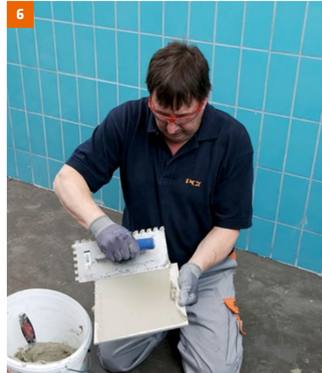
... wird das Buttering-Floating-Verfahren angewendet.
