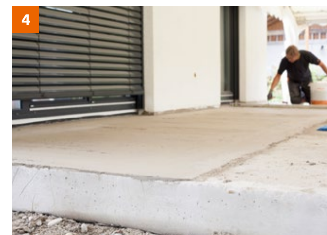
Fertiggestellte Teilfläche mit PCI Pericret.
