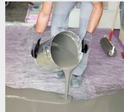
Die Bodenausgleichsmasse PCI Periplan Extra in einer Mindestdicke von 10 mm ausgießen.
