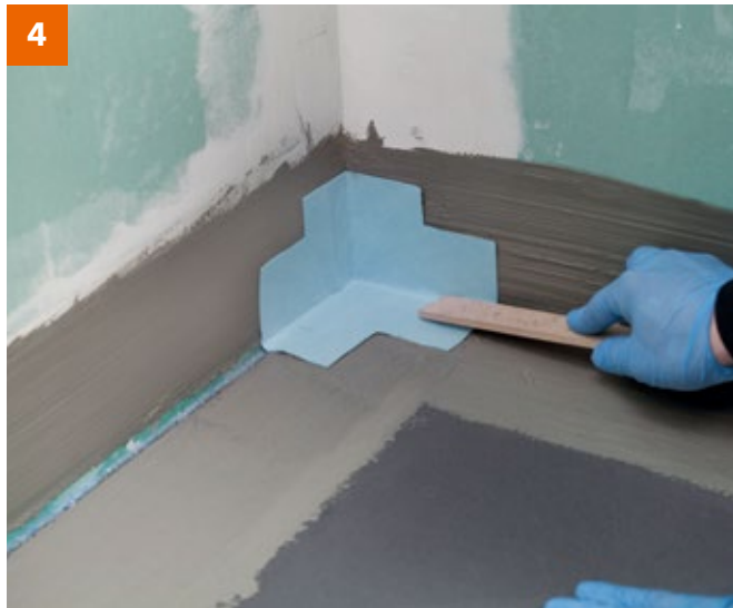
Einlegen der vorgefertigten Spezial-Innenecke PCI Pecitape 90° I in PCI Seccoral 1K / 2K Rapid.
