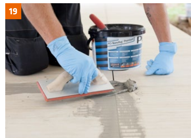
Fliesenbelag mit PCI Nanofug Premium einfügen ...
