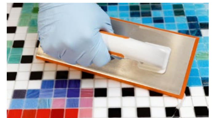
Sehr geschmeidiges Einfugverhalten, wie ein zementärer Fugenmörtel, und auch leicht zu Waschen.
