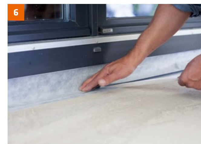
Detail Türabdichtung mit PCI Pecitape WS: vorher gründlich reinigen.
