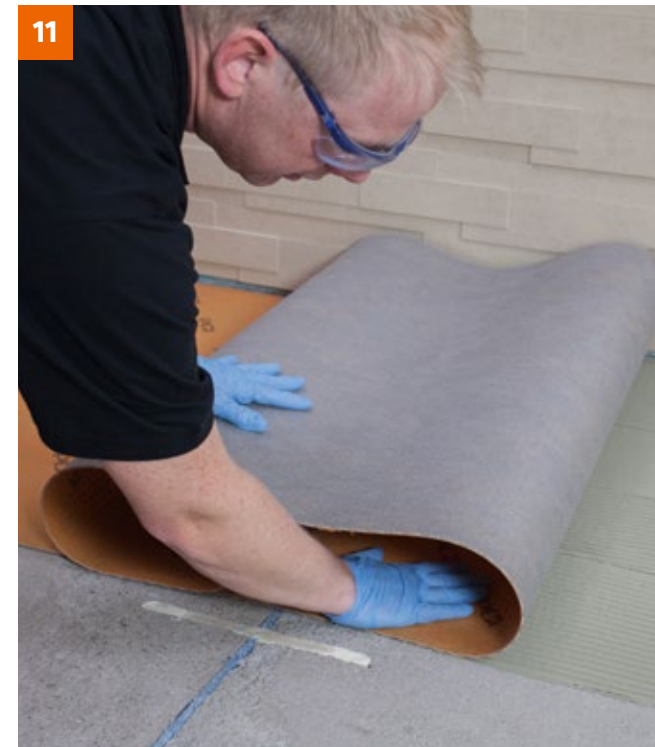
Nach ca. 40 Minuten wird PCI Pecilastic U mit PCI Flexmörtel S2 als Entkopplungsschicht auf dem Estrich verklebt.
