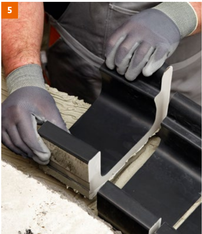
... Formteil frisch in frisch setzen ...
