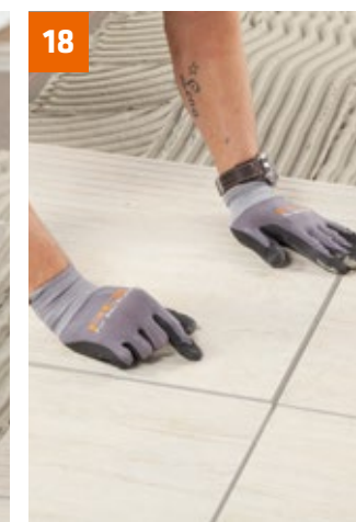
... einschieben und ggf. mittels Gummihammer einklopfen. Danach ausrichten.
