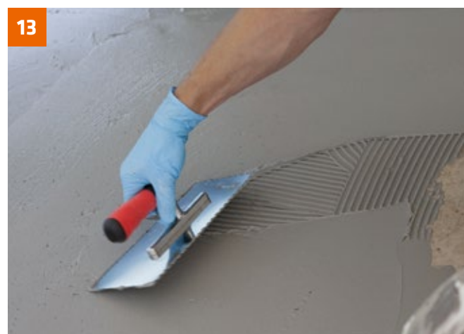
PCI Seccoral 2K Rapid mit 6er Zahnung aufkämmen und anschließend glattstreichen; nach ausreichender Trocknung der ersten Schicht den zweiten Auftrag in gleicher Weise vornehmen.
