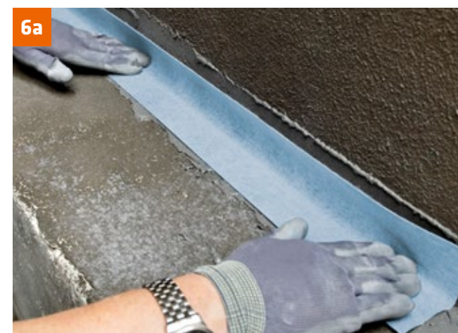
... dann das Abdichtband PCI Pecitape Objekt in die frische Dichtschlämme eingelegt und behutsam angedrückt. Die Ränder des Dichtbandes werden anschließend mit PCI Seccoral 1K / 2K Rapid überarbeitet.
