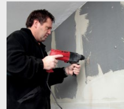
Nach Erhärtung des Klebemörtels werden die Bohrungen für die Dübel (ca. 5 Stck./m²) gesetzt.
