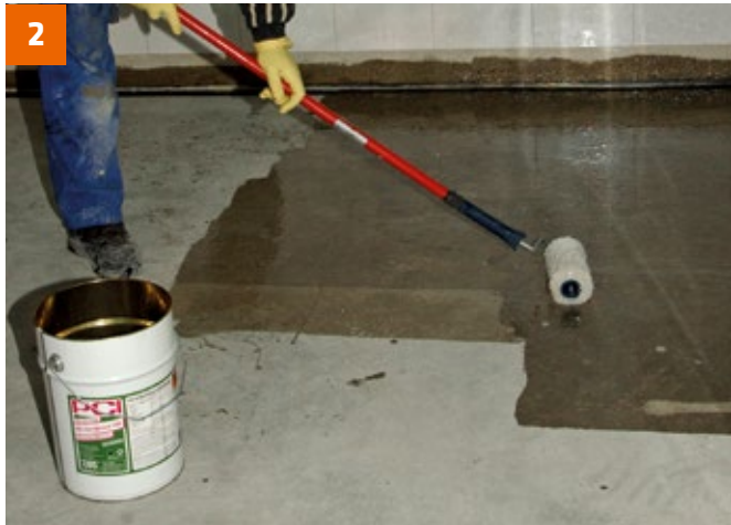
Untergründe vorbereiten, Verunreinigungen und nicht tragfähige Bereiche entfernen und ausgleichen. Mit PCI Epoxigrund 390 grundieren.
