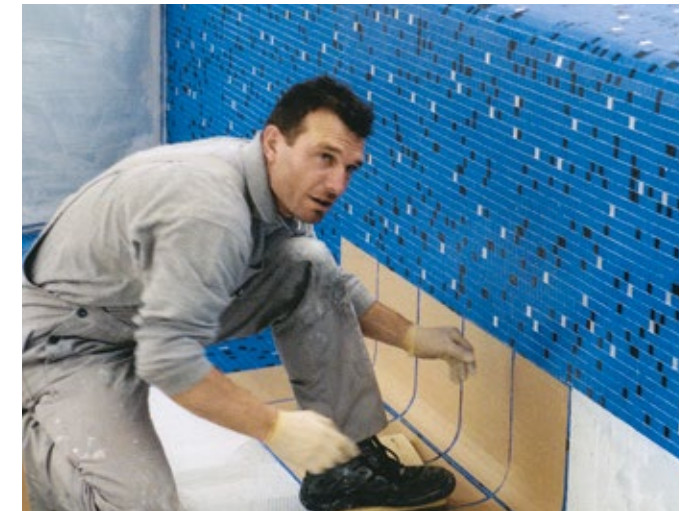
... werden keramische Beläge sicher auf Stahlkonstruktionen verlegt.
