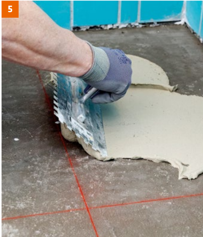
Auch bei der Verlegung der Bodenfliesen ...
