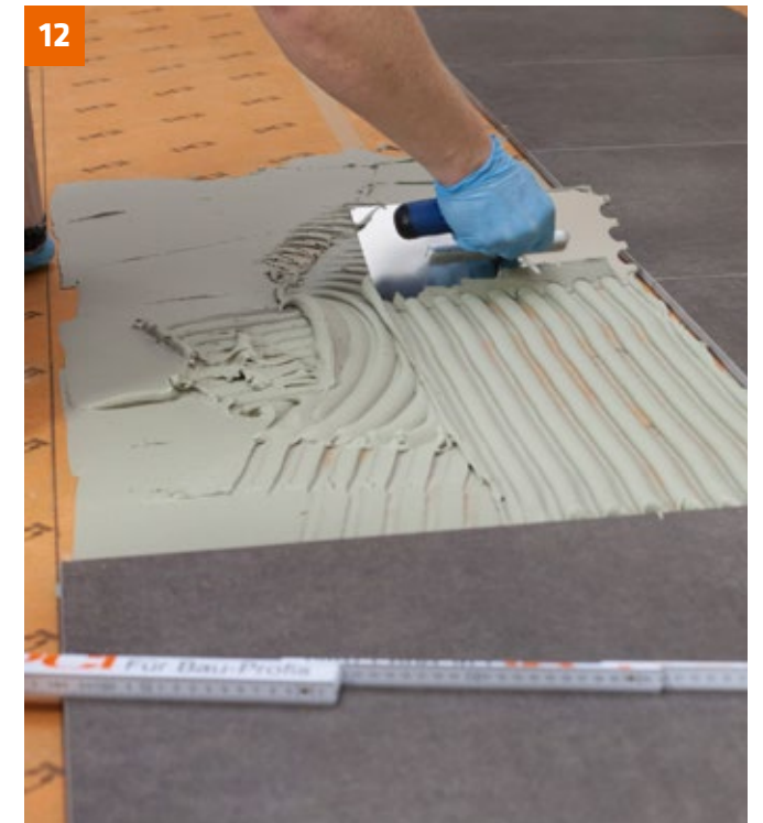
Auch die Bodenfliesen werden mit PCI Flexmörtel S2 verlegt.
