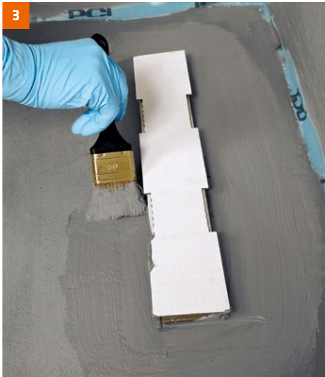
PCI Seccoral 1K / 2K Rapid als Kleber für das werksseitig mitgelieferte Gewebe vorlegen ...
