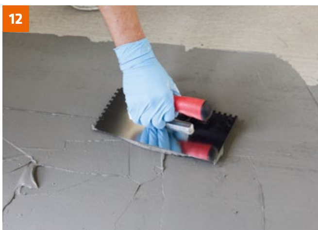
Kratzspachtelung mit PCI Seccoral 2K Rapid ausführen.
