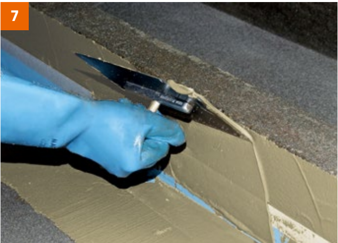
Anschließend noch einmal mit PCI Apoflex überarbeiten.
