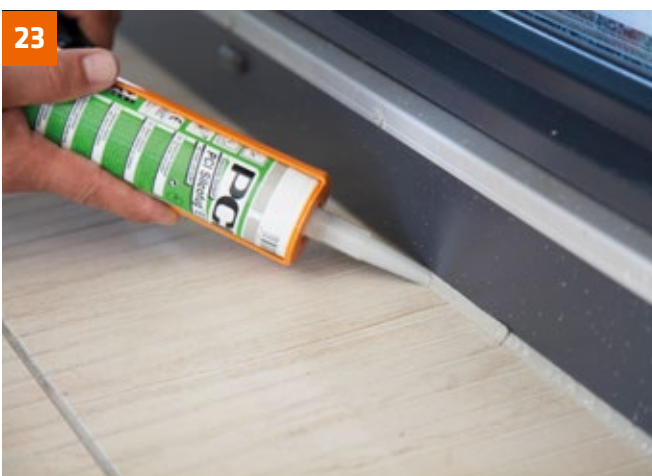
Silikonieren mit PCI Silcofug E oder PCI Silcoform S im Anschlussbereich zum Kunststofffenster.
