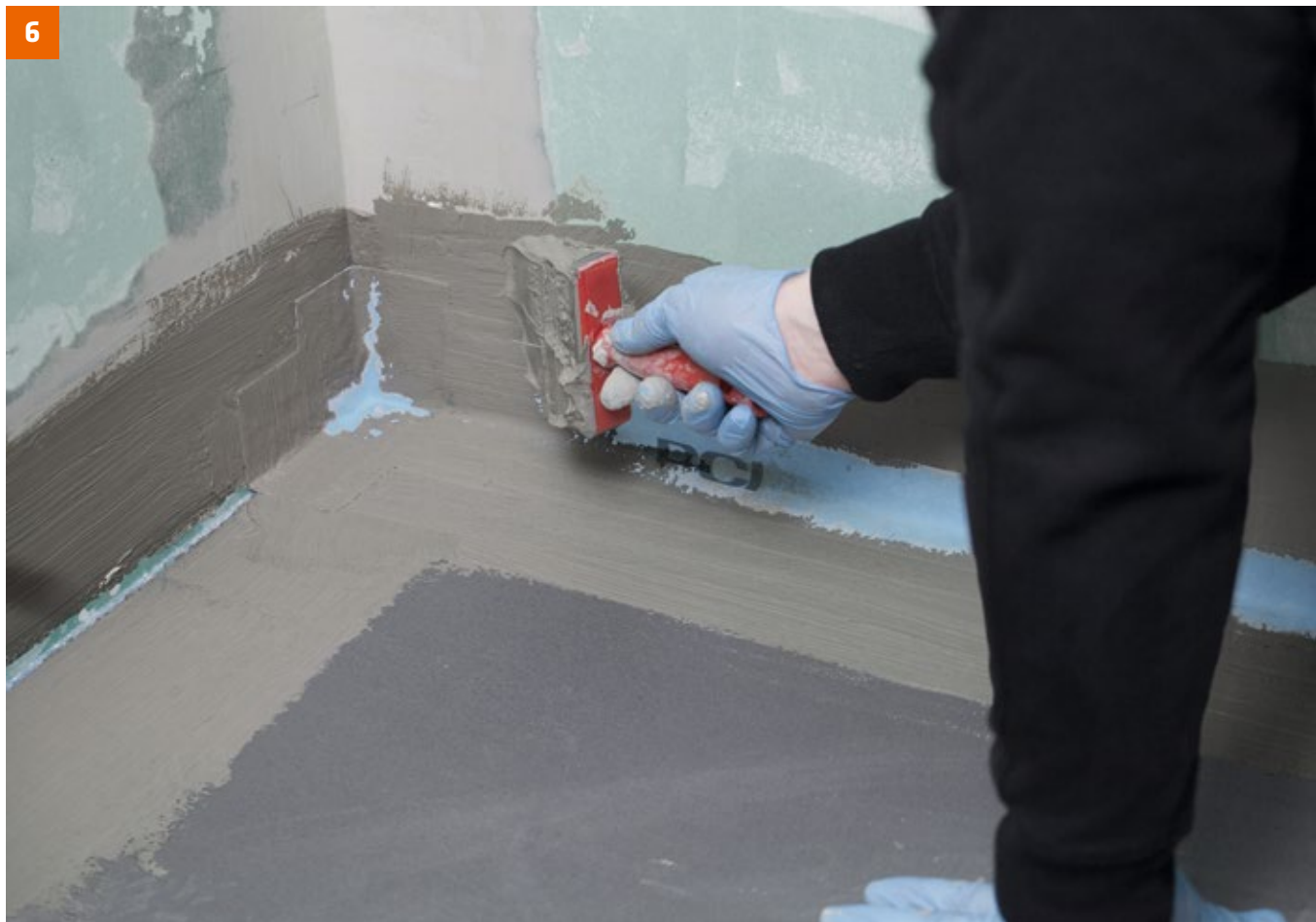
... und die vlieskaschierten Bereiche mit PCI Seccoral 1K / 2K Rapid überstreichen.
