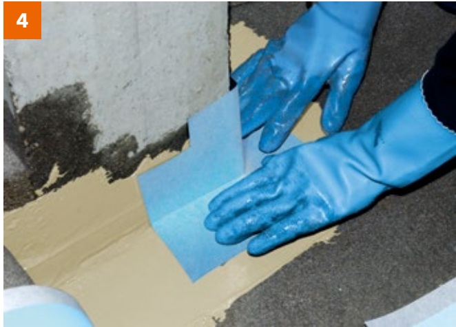
Formteil PCI Pecitape 90° in die Abdichtungsschicht einlegen ...
