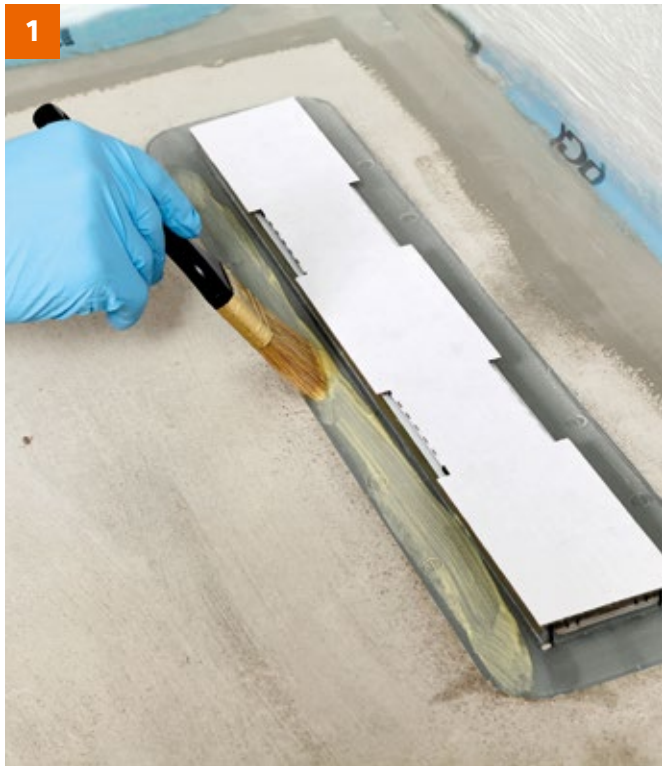
Grundierung des Anschlussflansches mit PCI Epoxigrund 390.
