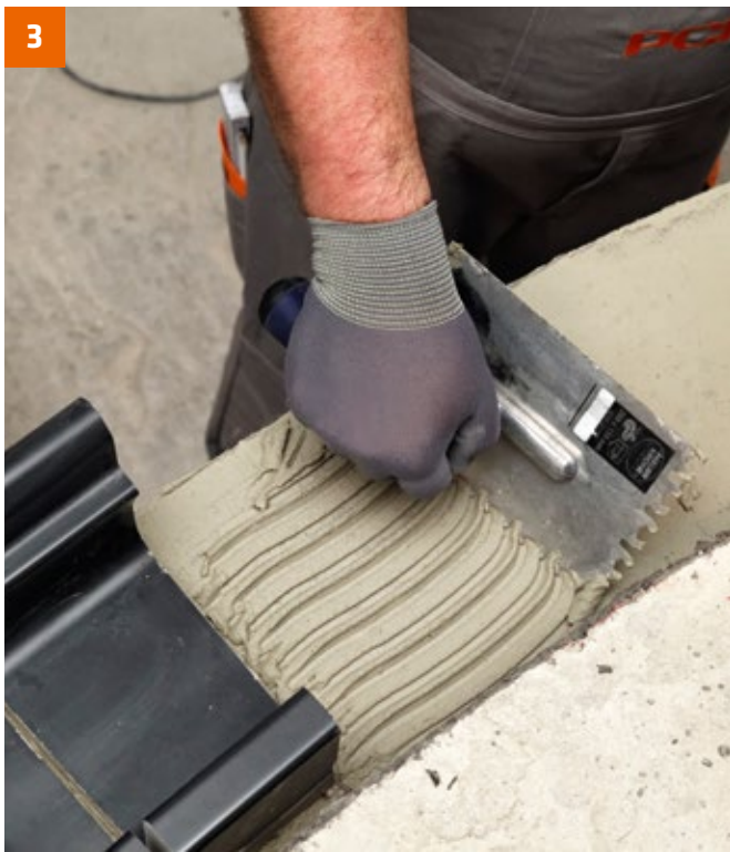
... und dann das Kleberbett aufkämmen.
