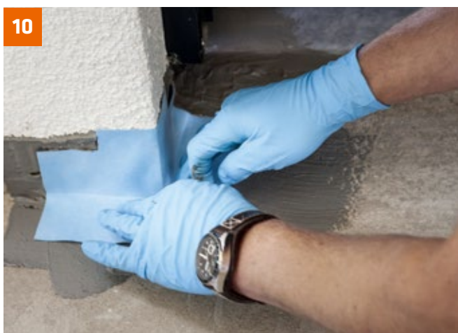
Detail Wandanschluss: PCI Seccoral 2K Rapid vorlegen und Außenecke einlegen.
