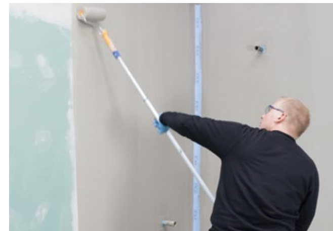
Flüssigabdichtungen sind immer mindestens 2-lagig auszuführen.
