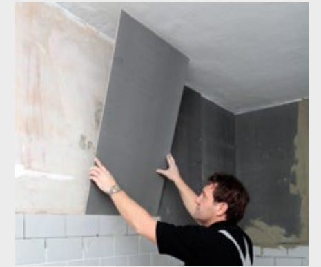
PCI PowerBoard-Element ansetzen und anschließend anklopfen.
