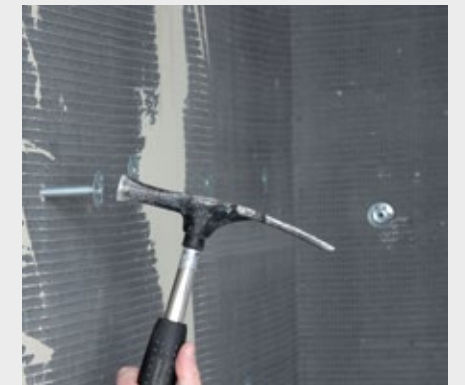
Zu guter Letzt die Schlagdübel einschlagen.
