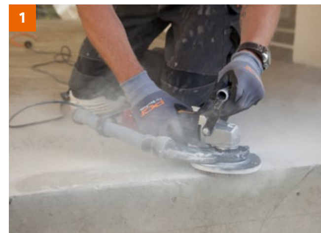
Untergrundvorbereitung: Grate entfernen.
