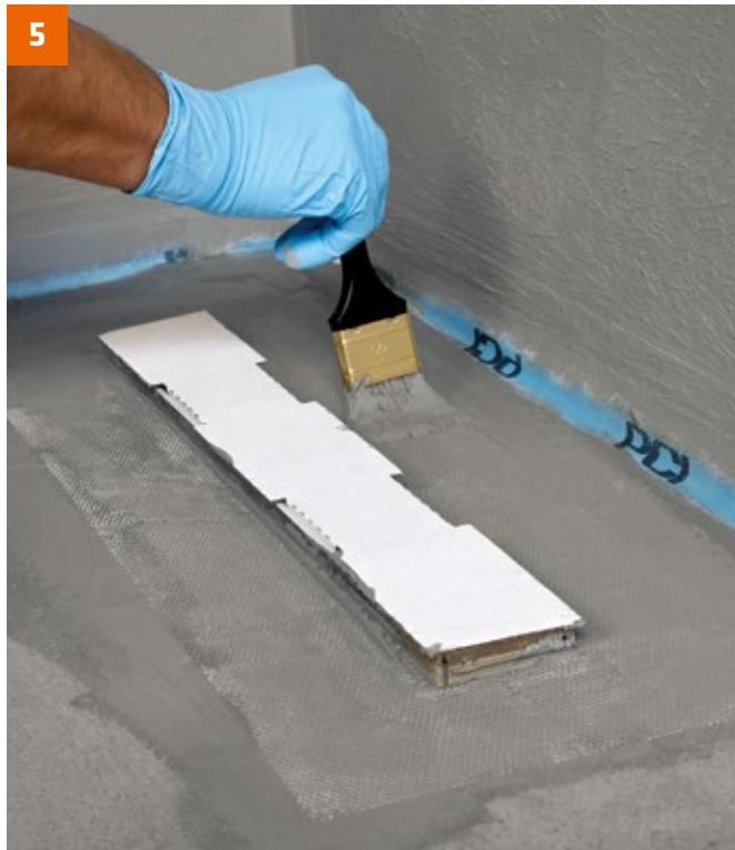
... und mit etwas Abdichtungsmaterial nochmals überstreichen.
