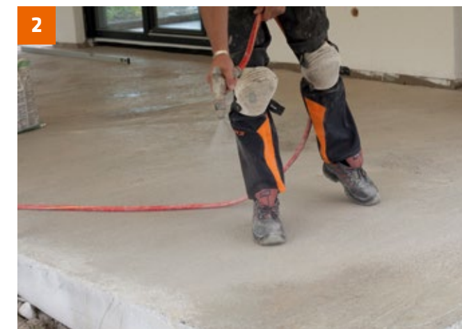
Untergrund vornässen für die Aufbringung der Ausgleichsspachtelung.
