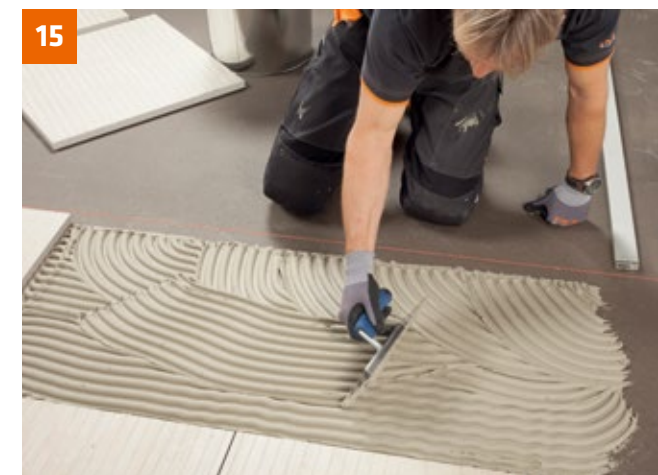
PCI Nanorapid Kleberbett aufziehen.
