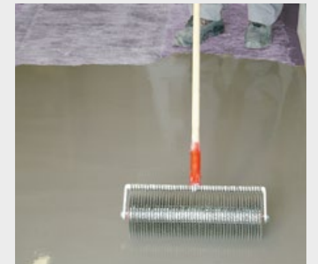
... und mit einer geeigneten Stachelwalze entlüften.
