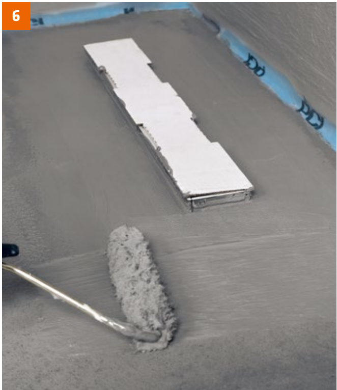
Anschließend die Entwässerungsrinne mit zwei Arbeitsgängen in die Flächenabdichtung einbinden.
