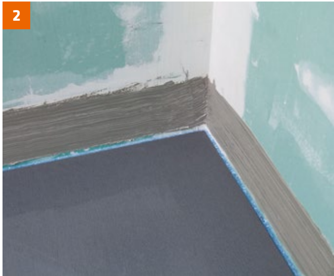
Anschließend wird zum Verkleben des Sicherheits-Dichtbands PCI Pecitape120 das Abdichtungsmaterial PCI Seccoral 1K / 2K Rapid an der Wand vorgelegt.
