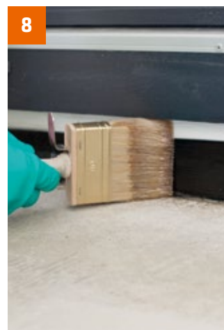
Element grundieren mit PCI Epoxigrund 390 ...
