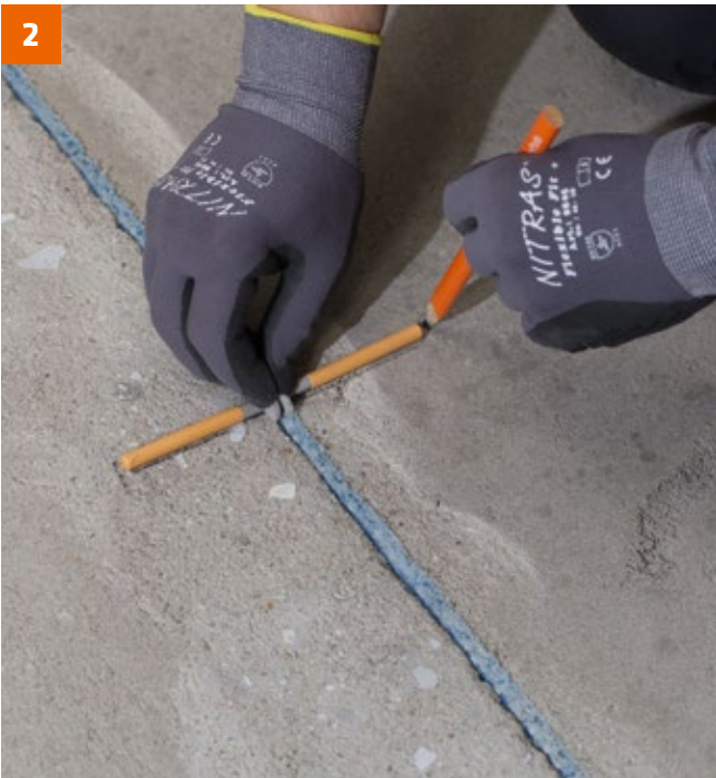
Nach dem Säubern der Dehnungsfuge wird die Position des PCI Apogel Dübels angezeichnet.
