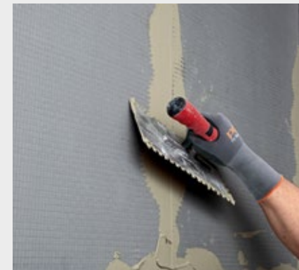
Die Plattenstöße und Anschlüsse werden mittels Klebemörtel beigespachtelt. Bei Bedarf kann auch zusätzlich ein Glasfasergewebe, zum Beispiel PCI Gewebbahn, eingespachtelt werden.
