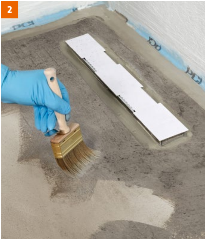
Die übrige Bodenfläche wird vorgehässt und mit verdünntem PCI Seccoral 1K / 2K Rapid grundiert.
