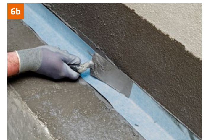
... dann das Abdichtband PCI Pecitape Objekt in die frische Dichtschlämme eingelegt und behutsam angedrückt. Die Ränder des Dichtbandes werden anschließend mit PCI Seccoral 1K / 2K Rapid überarbeitet.
