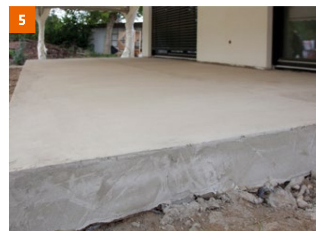
Terrassenplatte mit PCI Pericret im Gefälle gespachtelt.
