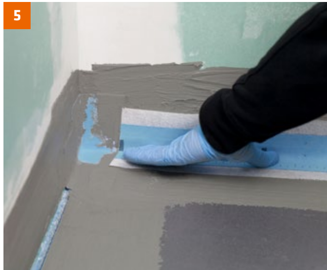
Dichtband PCI Pecitape 120 überlappend mit der Dichtecke einlegen...
