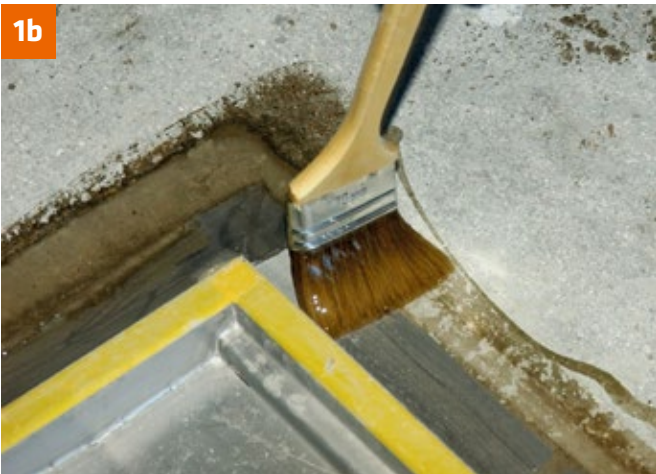
Details und Übergänge an Einbauteilen sowie Durchdringungen mit PCI Epoxigrund 390 grundieren.
