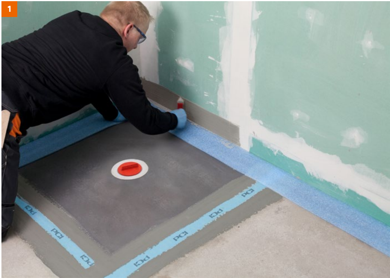
Um den Randdämmstreifen vor Kontakt mit dem Abdichtungsmaterial zu schützen, empfehlen wir diesen Bereich beim Arbeiten an der Wand sorgfältig abzudecken.
