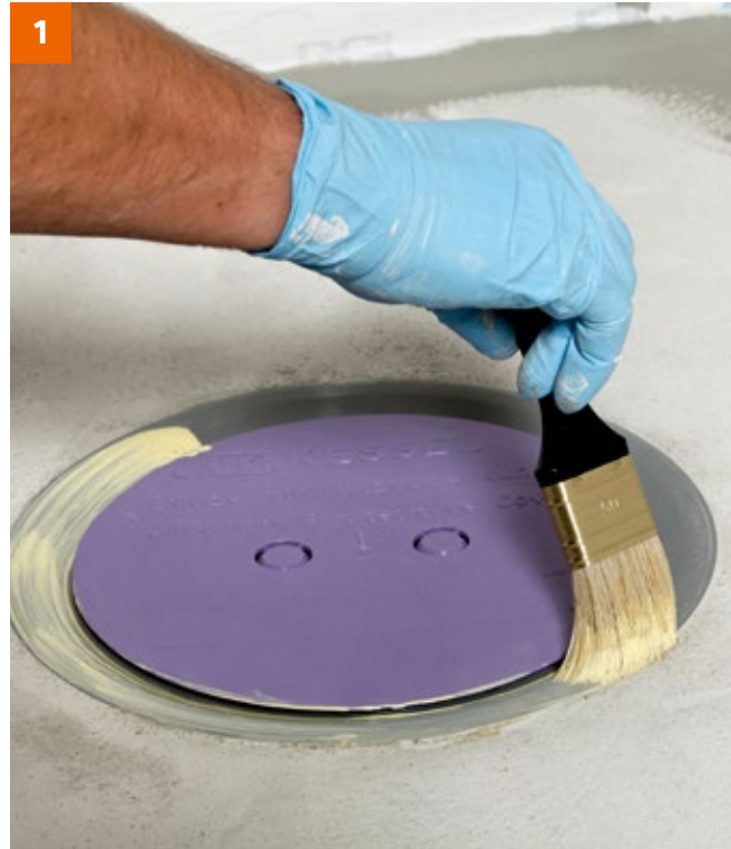
Grundierung des Flansches mit PCI Gisogrund 303 oder PCI Gisogrund 404.
