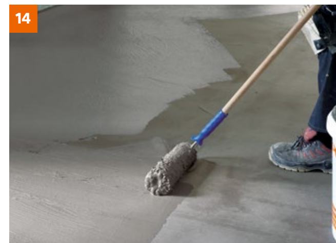
PCI Seccoral 2K Rapid kann auch – bis zum Erreichen der erforderlichen Trockenschichtdicke von 2 mm – mittels Lammfellrolle aufgetragen werden.
