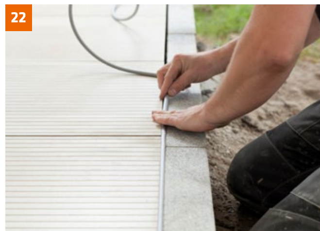
Danach die Rundschnüre einbauen für das nachfolgende Silikonieren.
