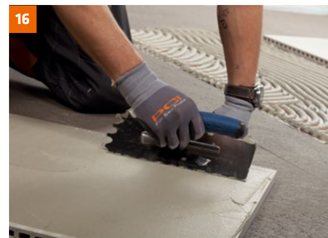
Kratzspachtelung mit PCI Nanorapid auf der Fliesenrückseite aufziehen ...
