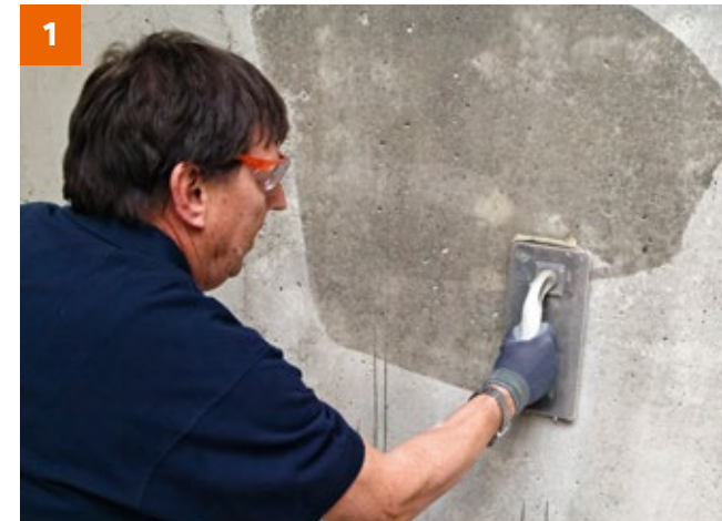
Das gründliche Vornässen reduziert die Saugfähigkeit des Betons und verhindert, dass der nachfolgenden Abdichtung zu schnell das Wasser entzogen wird.
