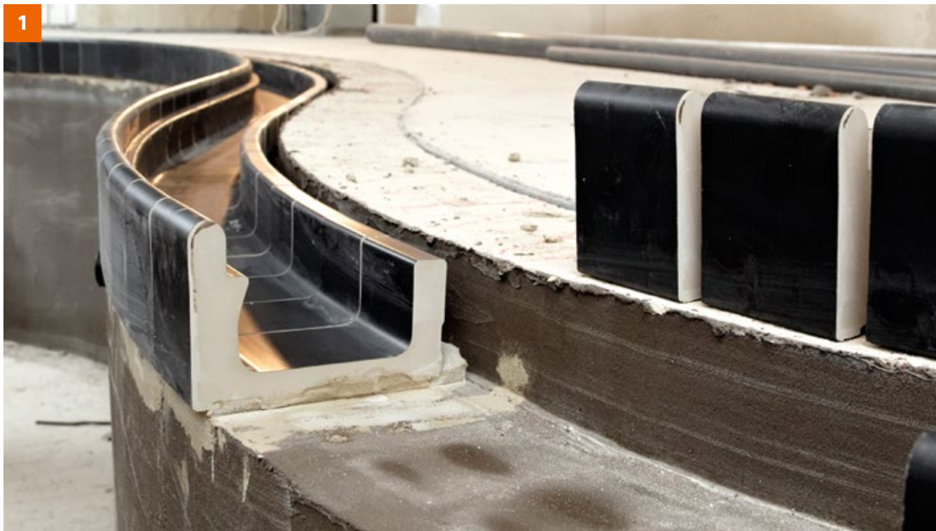
Rinnensteine zum Beispiel mit PCI FT Klebemörtel + PCI Lastoflex oder PCI Durapox NT plus hohlraumfrei setzen. Der Epoxidharz-Kleber hat eine kapillarbrechende Wirkung und kann im Dünn- und Mittelbettverfahren eingesetzt werden. Bei Kleberstärken > 5 mm PCI Carrament oder PCI FT Ment verwenden.
