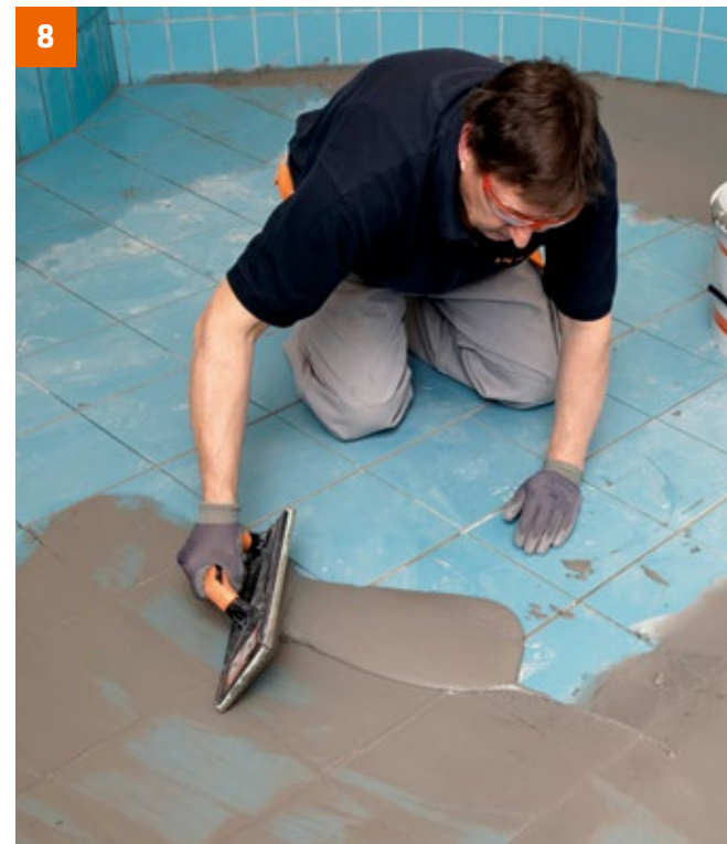
Am nächsten Tag erfolgt die Verfugung, zum Beispiel mit PCI Durafug NT. Die Fläche einschlämmen ...
