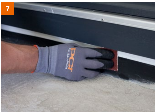
Detail Türabdichtung mit PCI Pecitape 120 / Objekt: Element anschleifen und anschließend reinigen mit PCI Univerdünner.
