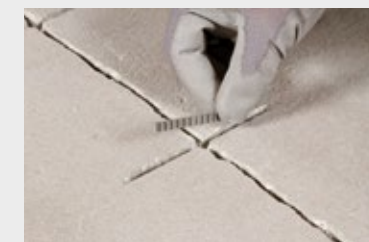
Estrichklammern in die quer zum Rissverlauf angelegten und ausgesaugten Nuten einlegen.
