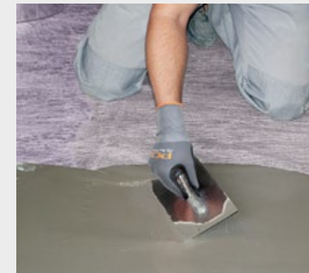
Mit einer Glättkelle oder Kufenraker verteilen (keine Stiftraker verwenden!) ...
