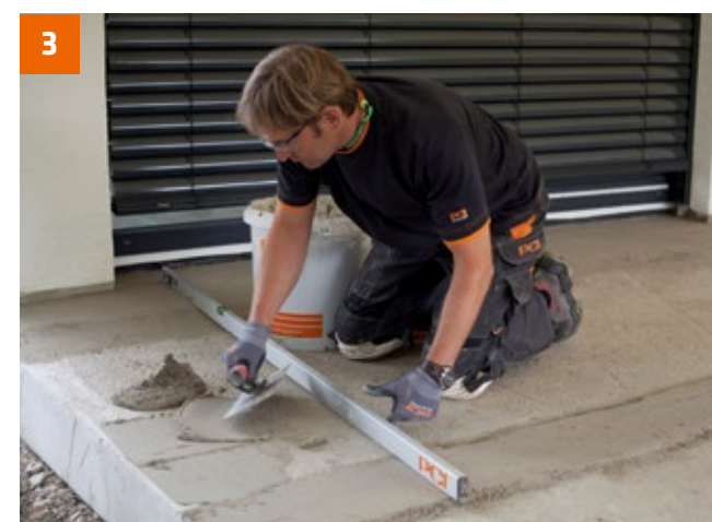
Lehren aufziehen und Flächenspachtelung mit PCI Pericret ausführen.
