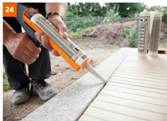
Silikonieren mit PCI Carraferm am Übergang zum Naturwerkstein.
