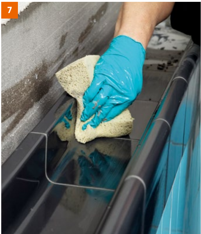
Sind die Rinnensteine gesetzt, kann nachfolgend zum Beispiel mit PCI Durafug NT oder PCI Durapox NT plus verfugt werden.
