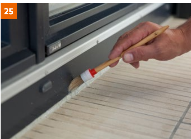
Zum leichteren Abziehen der Silikonfuge zum Beispiel PCI Glättmittel auftragen ...
