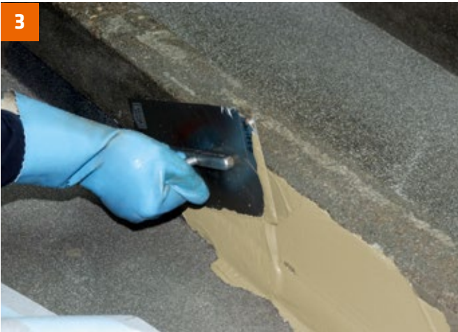
Vor dem Verkleben der Abdichtbänder wird PCI Apoflex vorgelegt.
