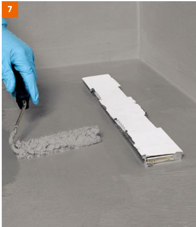
Nach einer Wartezeit von ca. 1 Stunde erfolgt jeweils nächste Auflag bis zum Erlangen der Mindesttrockenschichtdicke von 2 mm.
