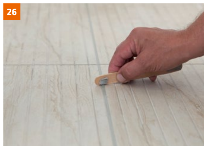
... und dann einfach die Fugen sauber abziehen.
