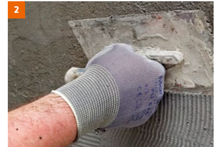
1. Auftrag PCI Seccoral 1K / 2K Rapid. Ziehen Sie die Abdichtung mit einem Zahnpachtel (6 mm) auf ...
