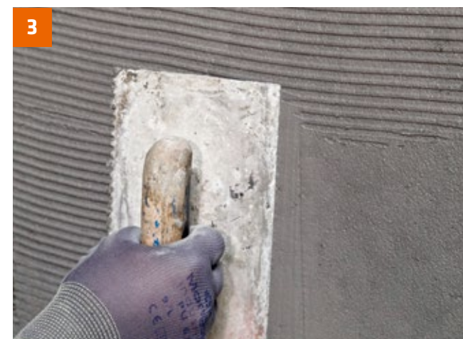
... und streichen Sie anschließend die Stege gleichmäßig zu.
