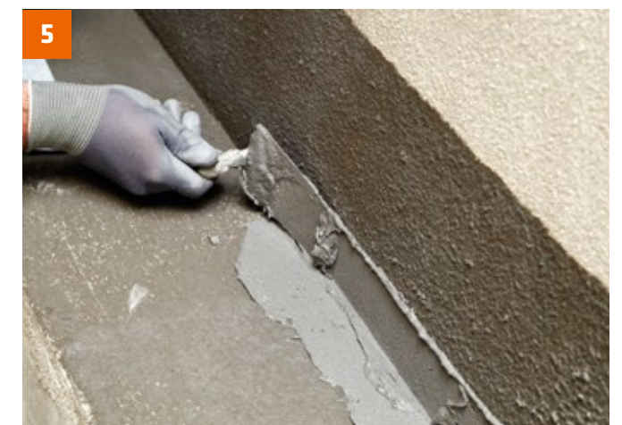
Zur Abdichtung von Kanten (zum Beispiel Wand-/Bodenanschlüssen) wird PCI Seccoral 1K / 2K Rapid vorgelegt ...
