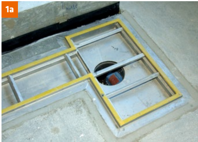
Einbauteile, Abläufe, Durchdringungen, Rinnen und Schwallmulden werden in die Flächenabdichtung eingebunden.
