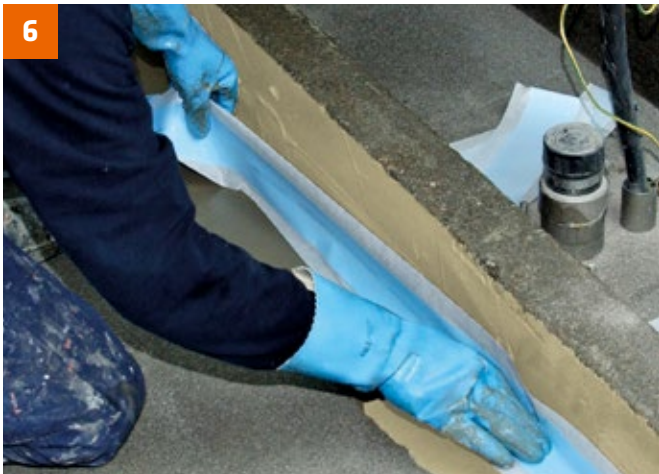
Danach wird zum Beispiel PCI Pecitape 120 oder PCI Pecitape Objekt eingelegt und übergearbeitet.
