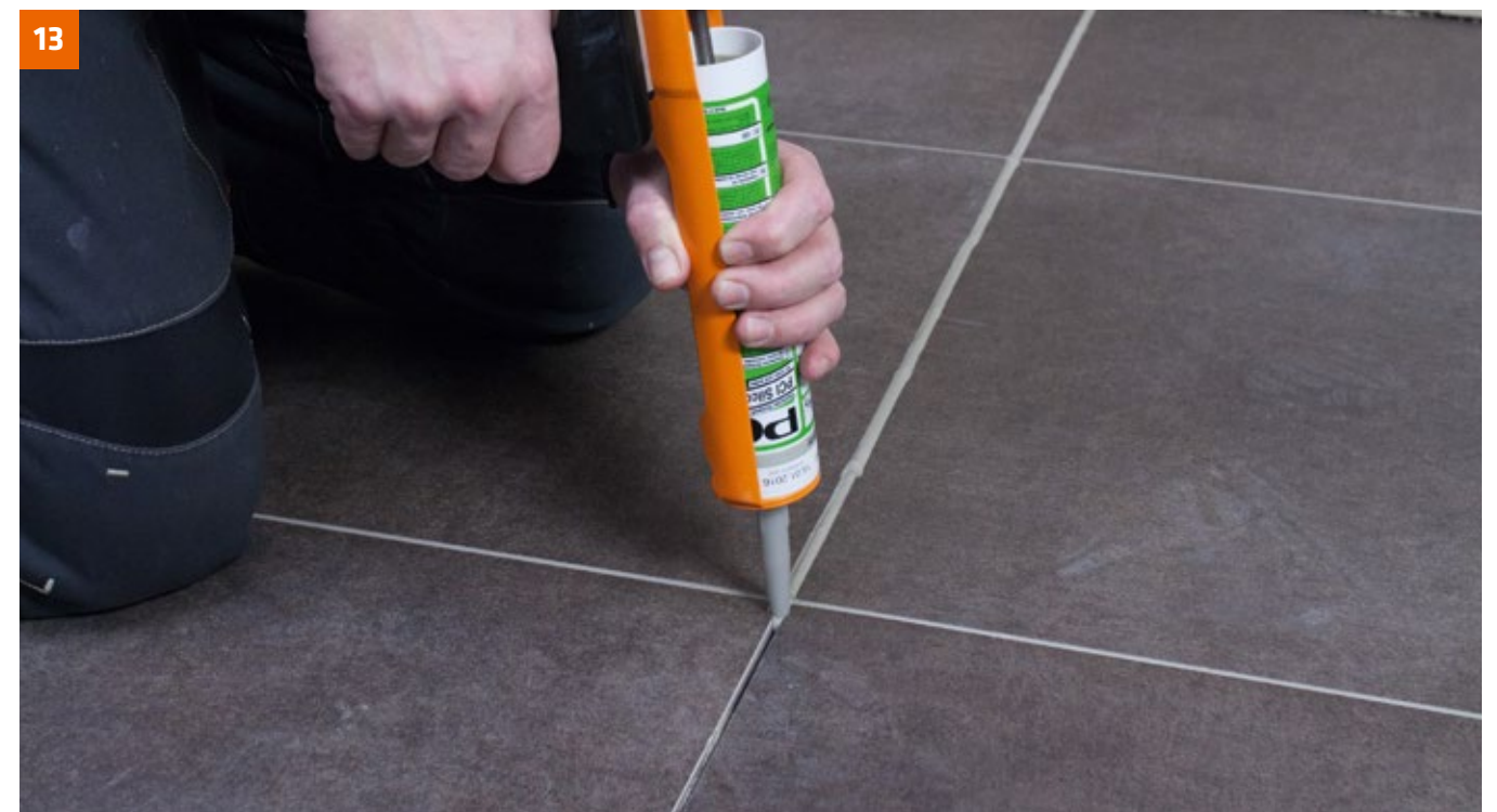
Nach dem Verfugen der Bodenfläche mit PCI Nanofug Premium wird die an die Trennfuge angrenzende Belagsfuge mit PCI Silcofug E versiegelt. Diese muss nicht breiter als die übrigen Belagsfugen ausgeführt werden und fügt sich so harmonisch in das Fugenbild ein.
