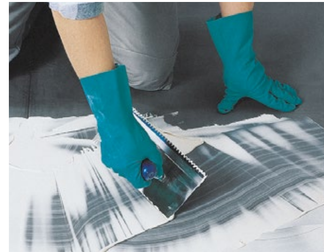
Mit dem verformungsfähigen Reaktionsharz-Fliesenkleber PCI Collastic ...
