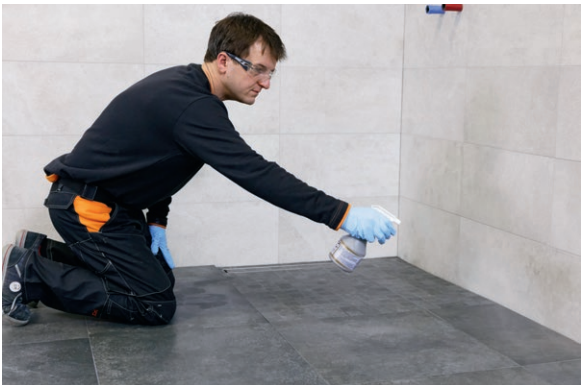
Vor dem finalen Waschgang wird nach ca. 60 Minuten PCI Durapox Finish (flüssig) auf die Fläche aufgesprüht. Alternativ kann auch PCI Durapox Finish (Konzentrat) direkt in das Waschwasser hinzugegeben werden.
