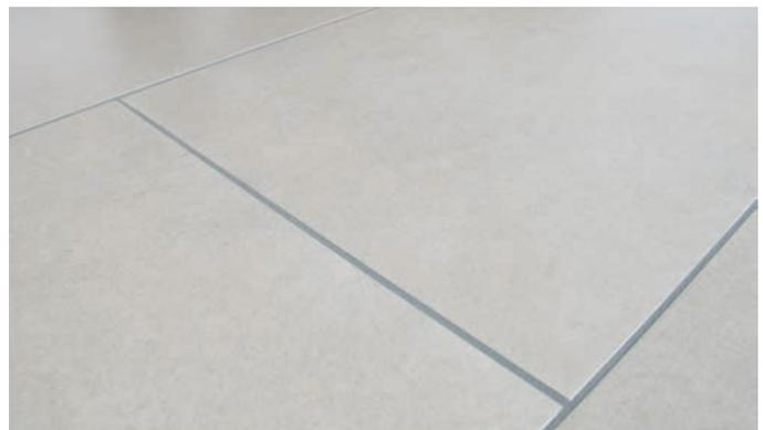
**Abb. 8 – Mit dem PCI Fugenvlies wird sehr wenig Wasser benötigt, um den Fugenmörtel zu glätten; der Lohn: Gleichmäßige, gut gefüllte Fugen**
