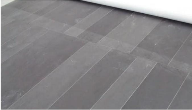
Abb. 10 – Feinstaub führte hier zu Verfärbungen; die Abdeckung wurde vor dem Entfernen nicht abgesaugt
