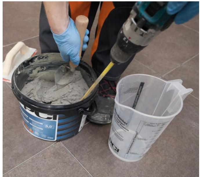
**Abb. 3 – Auch das Mörtelpulver am Eimerrand muss sorgfältig eingemischt werden**
