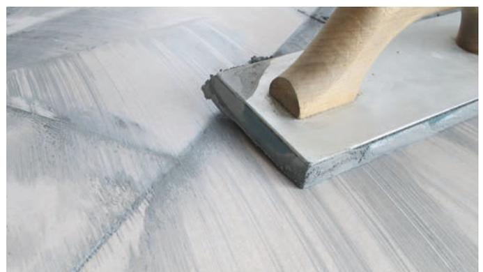
**Abb. 4 – Beim Nachfugen mit der Gummifugscheibe wird ein sehr guter Füllgrad erreicht**
