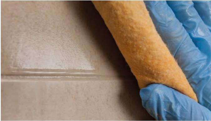
**Abb. 6 – Solche Wasseransammlungen müssen mit einem saugfähigen Vlies entfernt werden**
