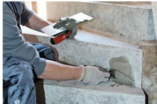
Der Blitz-Zement-Mörtel PCI Polyfix 5 Min. ist leicht zu verarbeiten und nur mit Wasser anzumischen.
