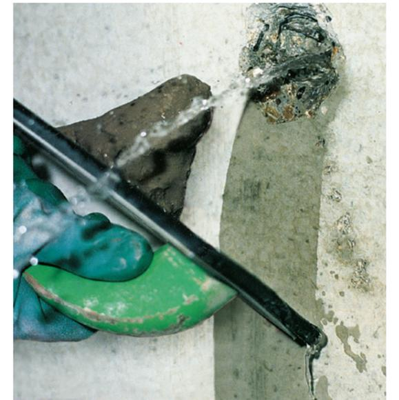
Mit dem Blitz-Montage-Mörtel PCI Polyfix 30 Sek. können Wassereintrübe schnell gestoppt werden.
