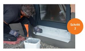
Das PCI Barraseal Ready Vlies vollflächig in die noch frische Schicht PCI Barraseal Ready einlegen und vorsichtig andrücken. **Hinweis:** Bei größeren Flächen die einzelnen Vlies-Bahnen mind. 5 cm überlappen lassen und mit einer Zwischenlage PCI Barraseal Ready verbinden.
