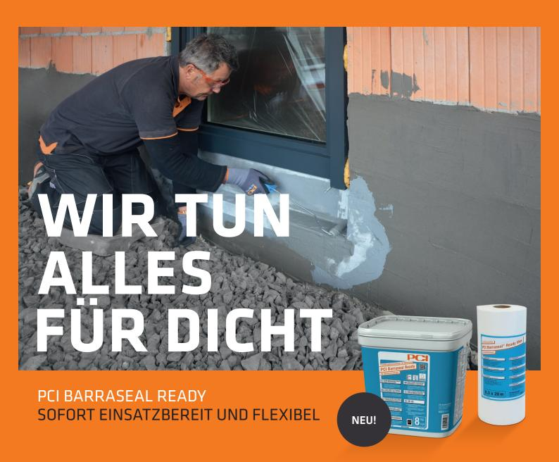
PCI Barraseal Ready ist eine gebrauchsfertige, flexible 1K-Abdichtung: Die einfache und sichere Lösung zum schnellen und dichten Einbinden bodentiefer Fenster- und Türelemente.
