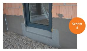
Die Abdichtung bis zur Aushärtung von PCI Barraseal Ready vor Wasser- und Frosteinwirkung schützen. Das Aufbringen einer Schutzschicht darf ebenfalls erst nach dem Aushärten der Abdichtungsschicht erfolgen.
