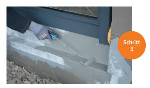
Das eingelegte PCI Barraseal Ready Vlies frisch in frisch mit einer zweiten Schicht PCI Barraseal Ready vollständig überarbeiten.
