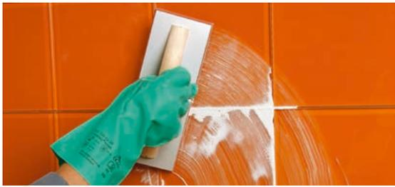
Einbringen des Fugenmörtels mit Fugenbrett.
