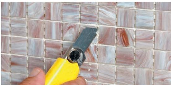
**Entfernen von überschüssigem Kleber aus der Fugenkammer.**
