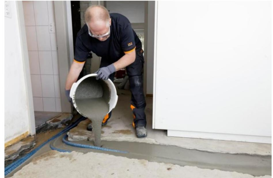
Einbau in fließfähiger Konsistenz
