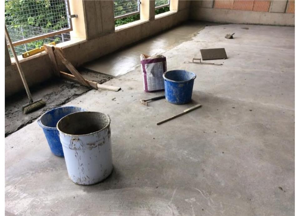
Nach Erstellen der vorderen Parkplatzflächen Einbau eines Gegengefalles zum Schutz der Außenwand
