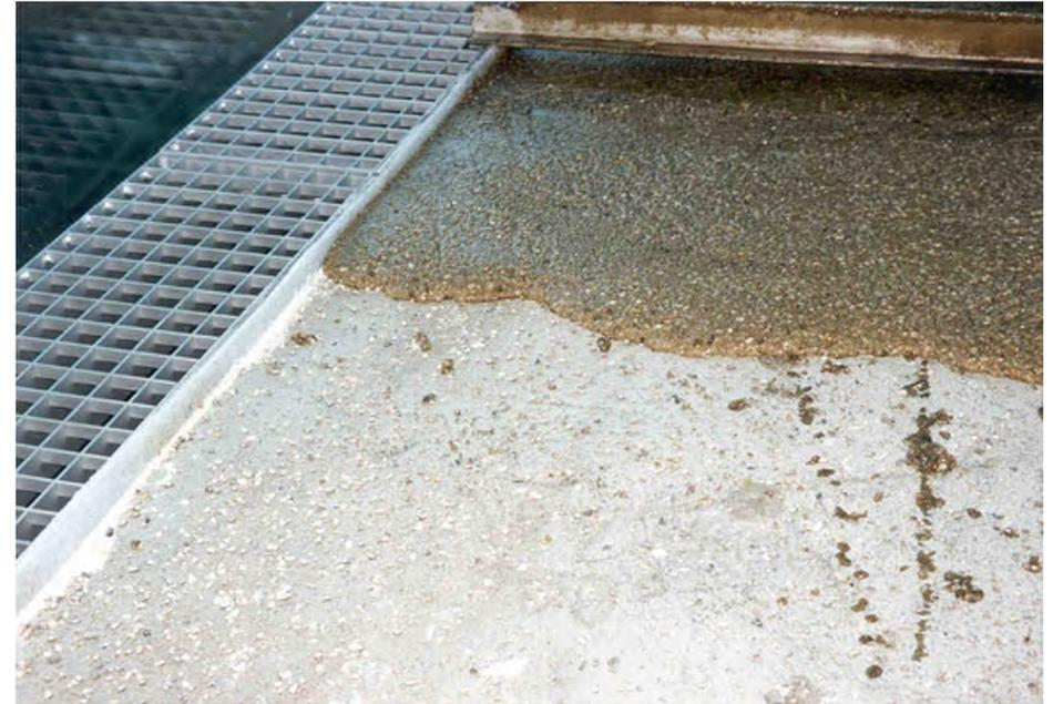
Einbau eines EP-Estrichs mit flüssigkeitsdichten Eigenschaften
