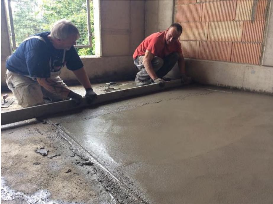
Tiefgaragenplätze sanieren, da Gussasphalt Druckstellen ergab und Gefälle zur Wand
