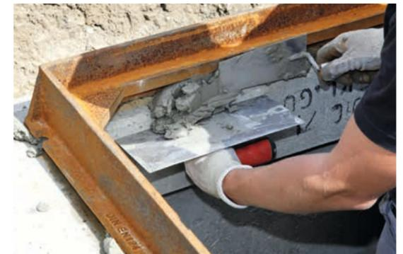
Der Schnell-Zement-Mörtel PCI Polyfix plus lässt sich ohne Haftbrücke aufbringen und härtet in nur 5 Minuten rissfrei aus.
