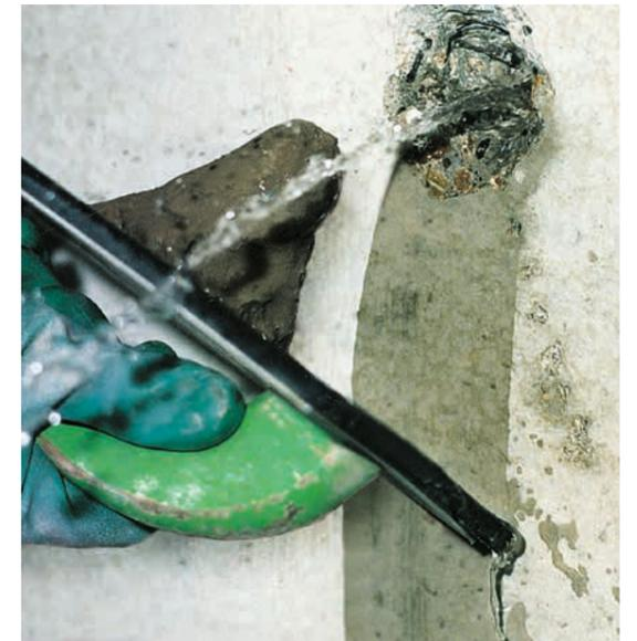
Mit dem Blitz-Montage-Mörtel PCI Polyfix 30 Sek. können Wassereinbrüche schnell gestoppt werden.
