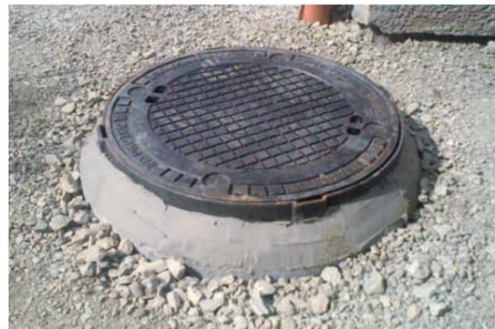
Schachtabdeckungen lassen sich zeitsparend mit PCI Polyfix plus L setzen.
