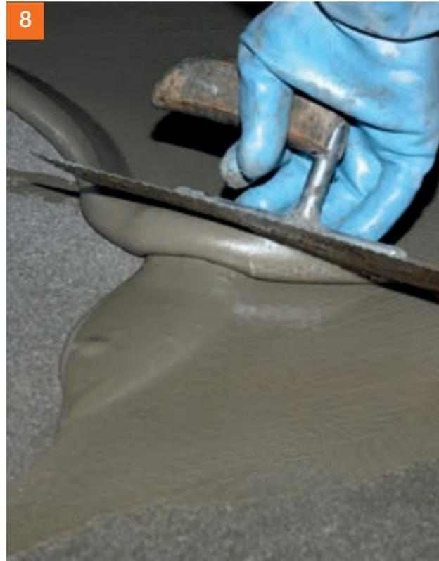
Anschließend noch einmal mit PCI Apoflex® überarbeiten.
