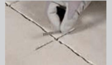
Estrichklammern in die quer zum Rissverlauf angelegten und ausgesaugten Nuten einlegen.
