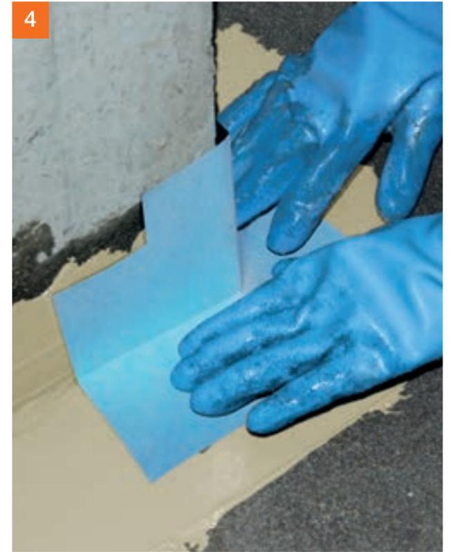
Formteil PCI Pectape® 90° in die Abdichtungsschicht einlegen ...
