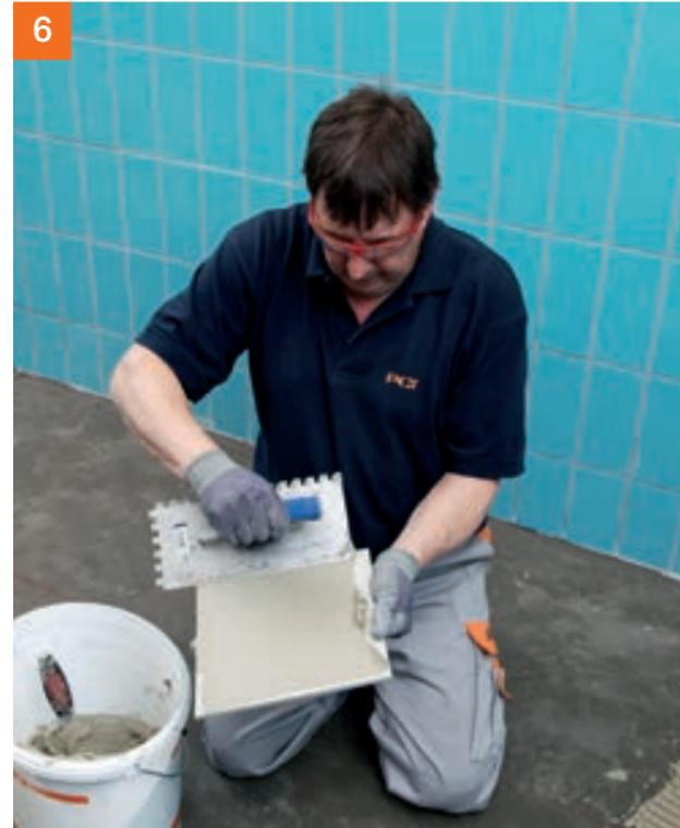
... wird das Buttering-Floating-Verfahren angewendet.
