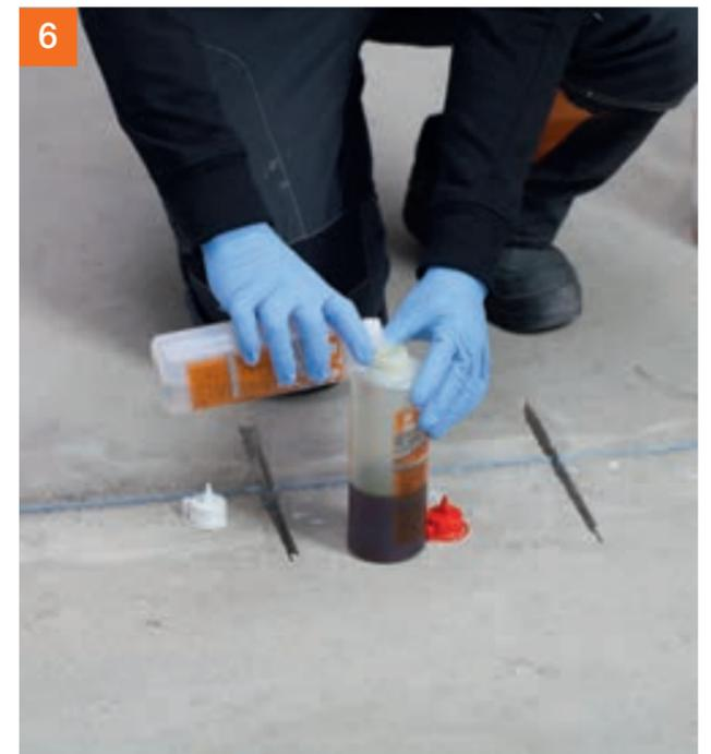
Sind die Nuten so weit vorbereitet, werden die beiden Komponenten von PCI Apogel® SH zusammengeschüttet ...
