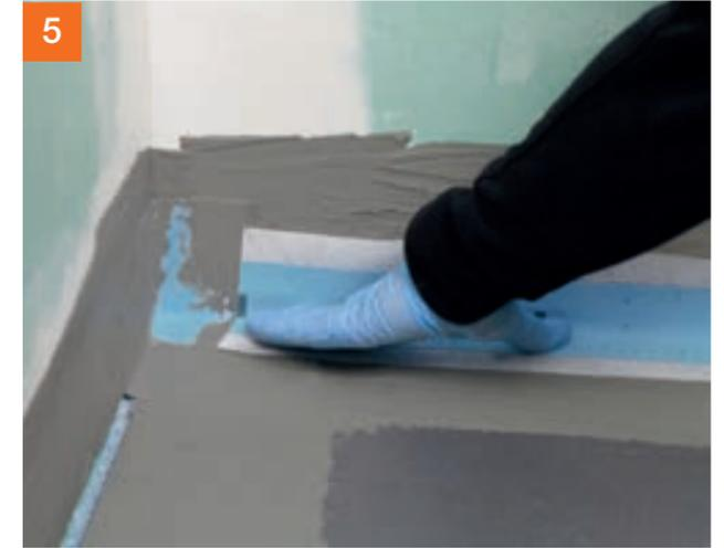
PCI Pectape® 120 die Dichttecke überlappend einlegen...
