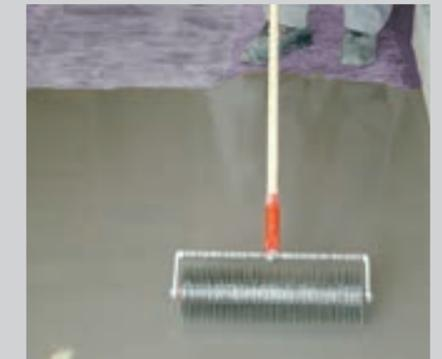
... und mit einer geeigneten Stachelwalze entlüften.
