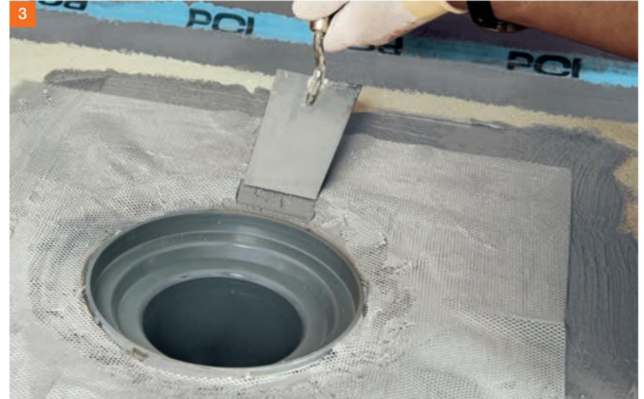
... anschließend das Gewebe entsprechend dem Gefälleverlauf andrücken und mit PCI Seccoral® 1K / 2K Rapid überarbeiten.
