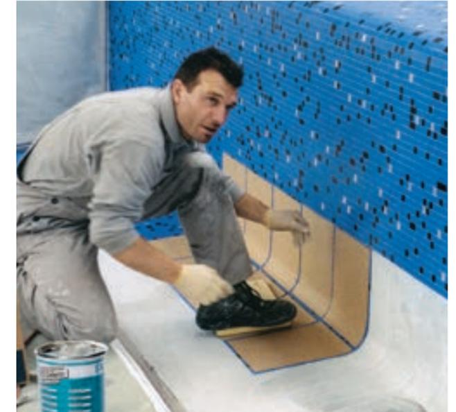
... werden keramische Beläge sicher auf Stahlkonstruktionen verlegt.
