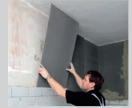
PCI PowerBoard-Element ansetzen und anschließend anklopfen.
