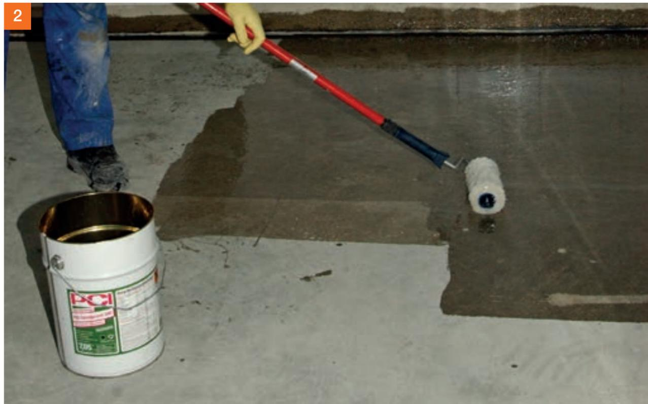
Untergründe vorbereiten, Verunreinigungen und nicht tragfähige Bereiche entfernen und ausgleichen. Mit PCI Epoxigrund 390 grundieren.
