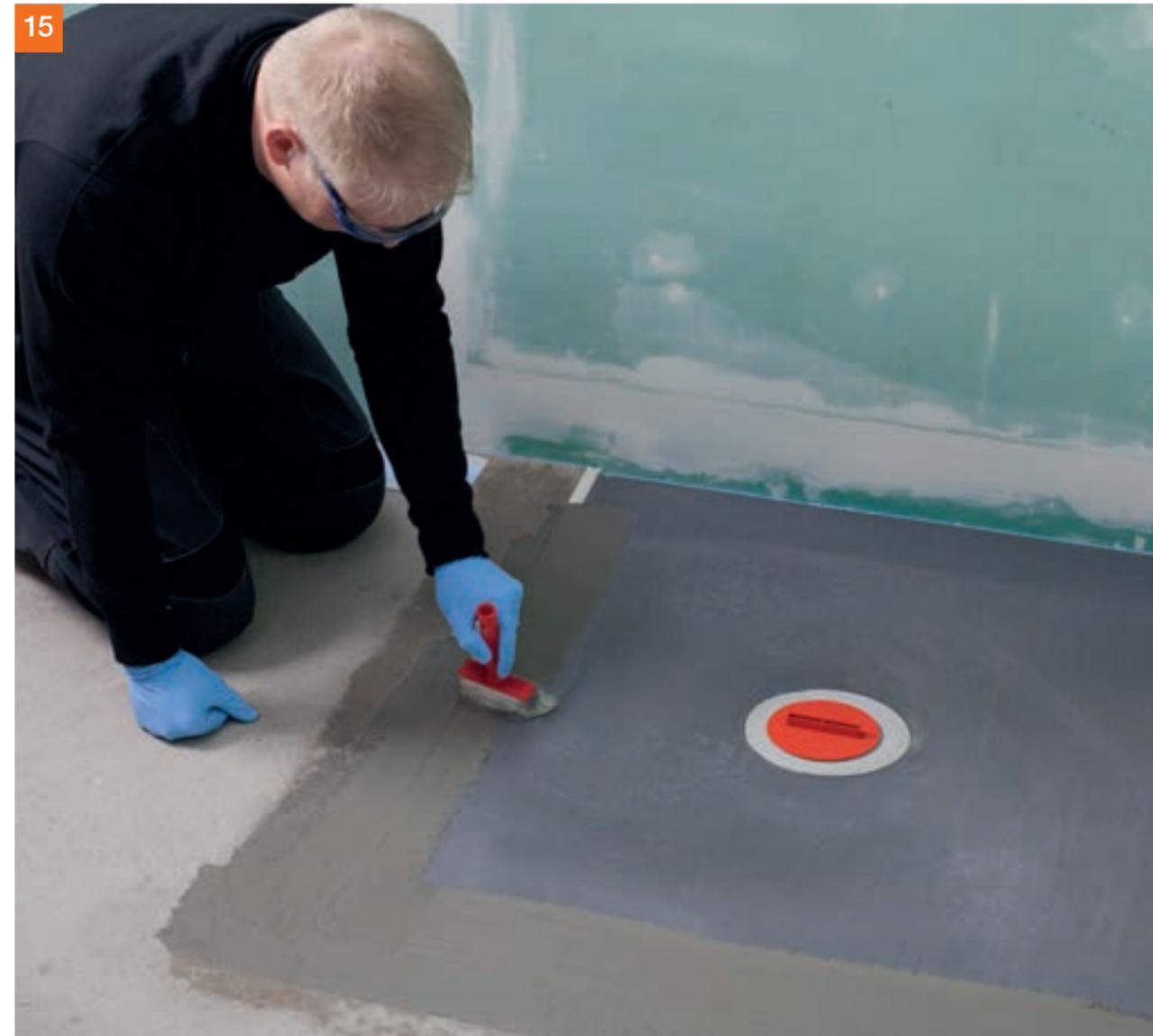
15 PCI Seccoral® 1K / 2K Rapid als Kleber für die Abdichtbänder vorlegen ...
