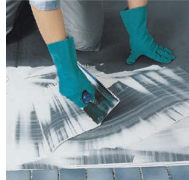
Mit dem verformungsfähigen Reaktionsharz-Fliesenkleber PCI Collastic® ...
