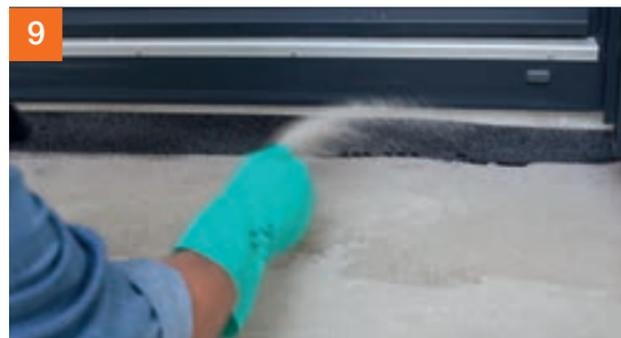
... anschließend die Grundierung absanden.
