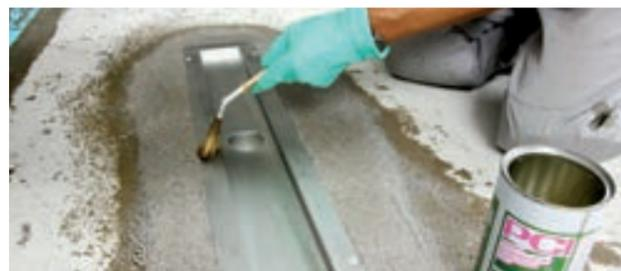
Nach dem Einbetten der Ablaufrinne im hoch wasserbeanspruchten Bereich mit Epoxidharz-Mörtel wird der Klebeflansch mit der Epoxidharz-Grundierung PCI Epoxigrund 390 oder PCI Elastoprimer 220 grundiert und im frischen Zustand mit feuergetrocknetem Quarzsand abgestreut.
