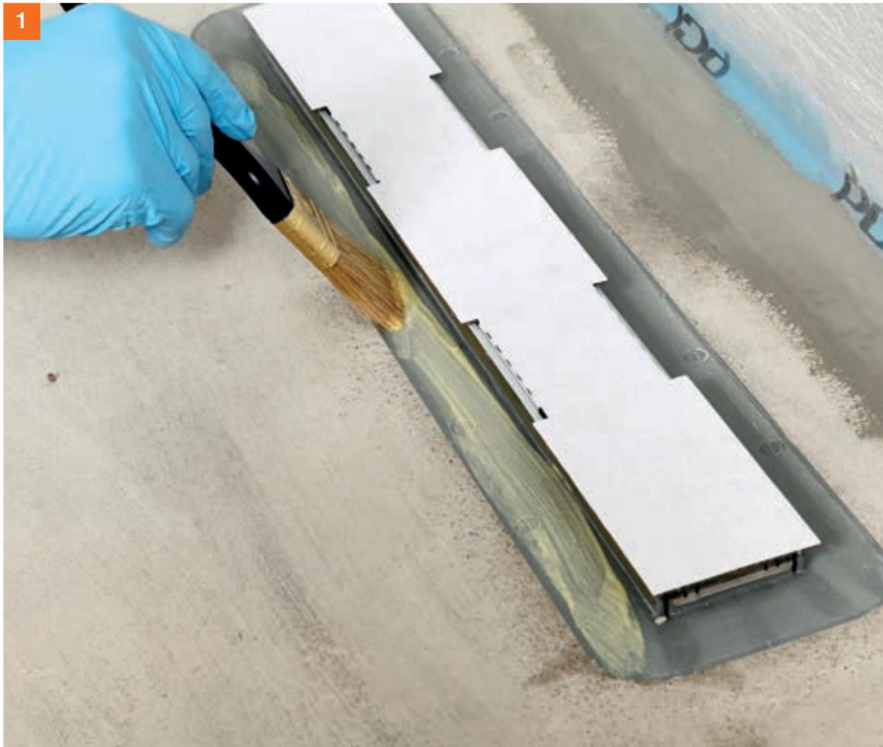
Grundierung des Anschlussflansches mit PCI Epoxigrund.
