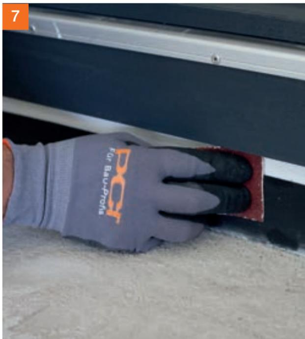
Detail Türabdichtung mit PCI Pecitape® 120: Element anschleifen und anschließend reinigen mit PCI Univerdüner.
