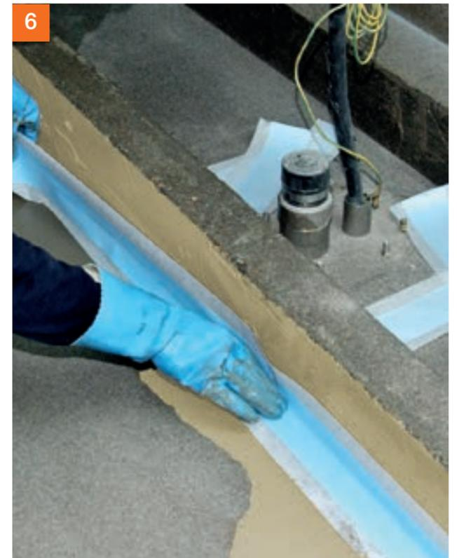
Danach wird zum Beispiel PCI Pectape® 120 oder PCI Pectape® Objekt eingelegt und übergearbeitet.
