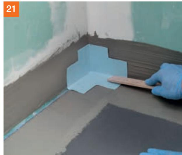
21 Vorgefertigte Spezial-Innenecke PCI Pecitape® ...
