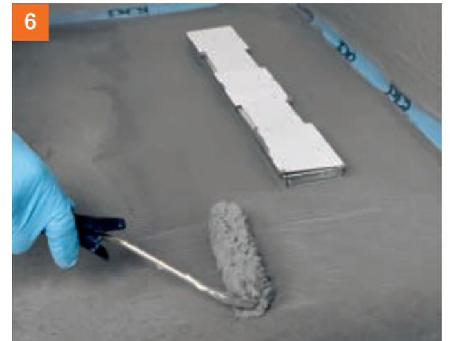
Anschließend die Entwässerungsrinne mit zwei Arbeitsgängen in die Flächenabdichtung einbinden.
