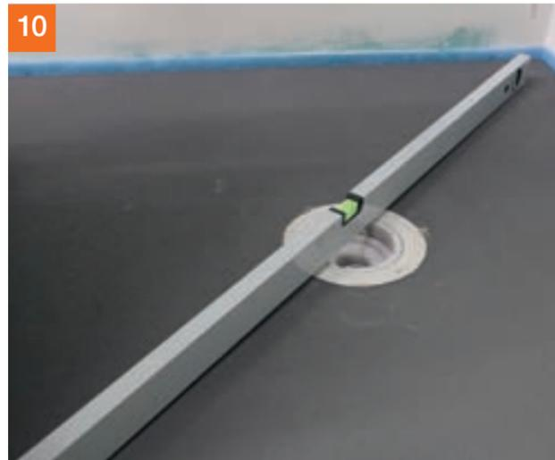
10 Korrekten Einbau mittels Wasserwaage prüfen und ...
