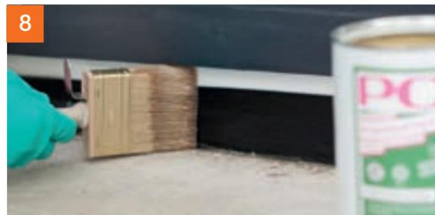
Element grundieren mit PCI Epoxigrund 390 ...
