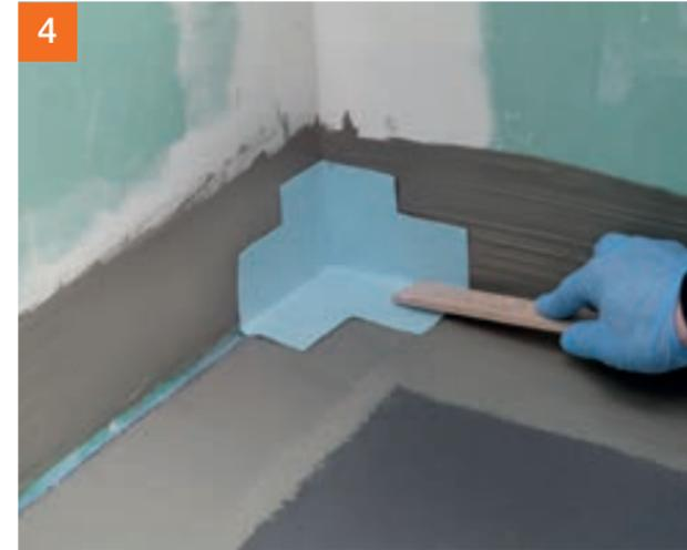
Einlegen der vorgefertigten Spezial-Innenecke PCI Pectape® 90° I in PCI Seccoral® 1K / 2K Rapid.
