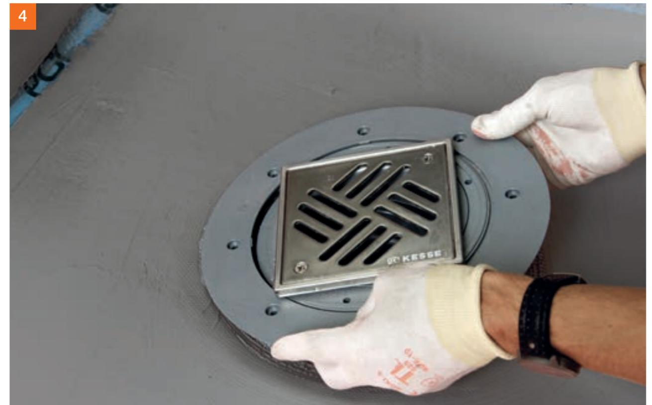
Klemmflansch aufsetzen und festschrauben.
