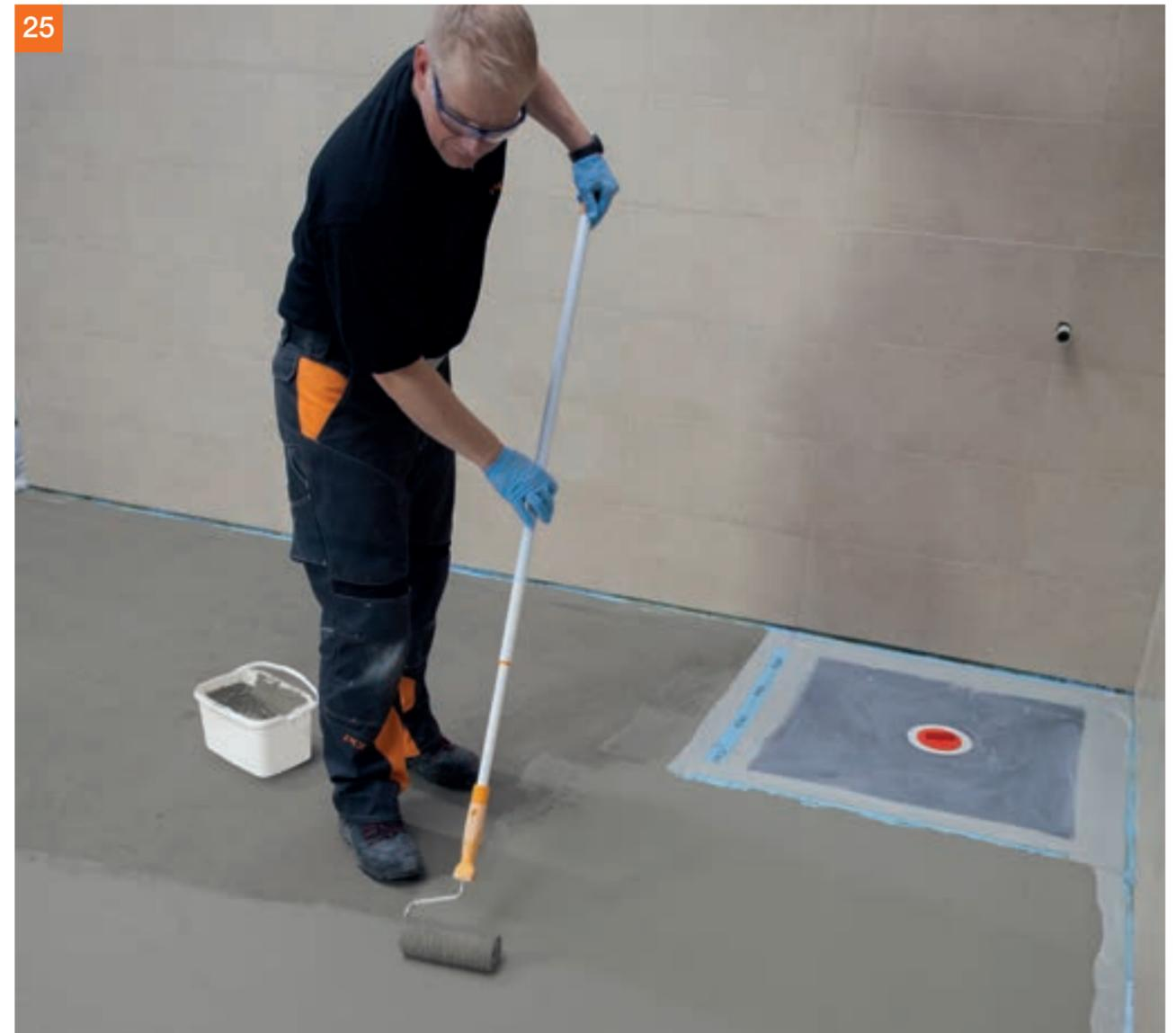
25 Nach ca. 1 Stunde erfolgt der jeweils nächste Auftrag mit PCI Seccoral® 1K / 2K Rapid bis zum Erlangen der Mindesttrockenschichtdicke von 2 mm.
