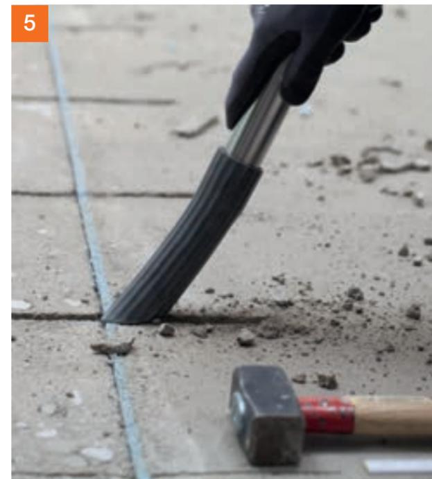
... und lose Estrichreste mittels Industriestaubsauger abgesaugt.
