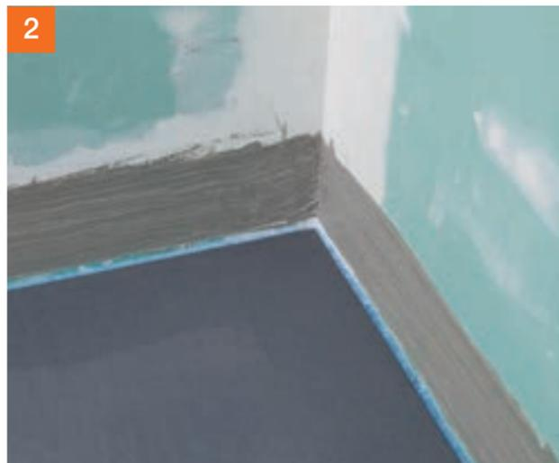
Anschließend wird zum Verkleben des Sicherheits-Dichtbands PCI Pectape® 120 das Abdichtungsmaterial PCI Seccoral® 1K / 2K Rapid an der Wand vorgelegt.
